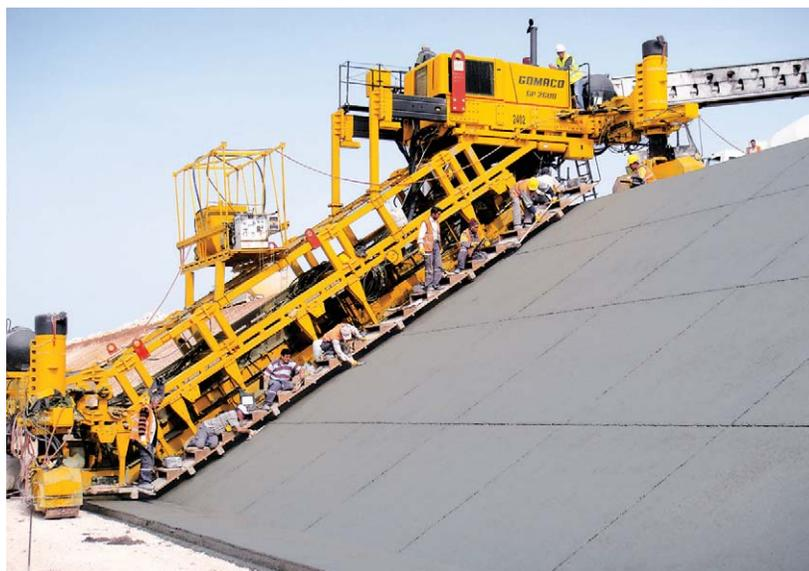
La GP-2600 est équipée du système de commande exclusif G+ de GOMACO. L'une de ses nombreuses fonctionnalités conviviales pour l'opérateur est sa capacité à se connecter facilement à n'importe quel système de pavage sans fil 3D ou ligne de référence.
