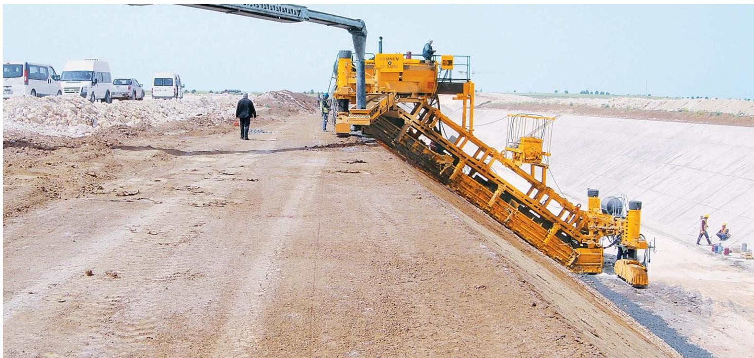
Une GP-2600 réalise la deuxième pente du canal. Le canal a une largeur de 10 mètres au fond et de 28 mètres au sommet, avec une pente de 10,8 mètres et des murs de pente de 1,5:1. Une fois terminé, le canal aura une profondeur d'eau de six mètres.
