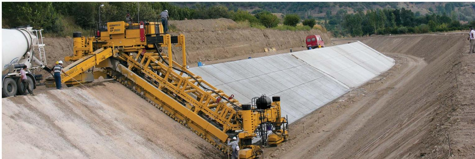
La GP-2600 a coulé du béton sur les pentes d'un canal, d'une largeur de 9,3 mètres en trois passes, sur un projet dans le nord de la Turquie.
