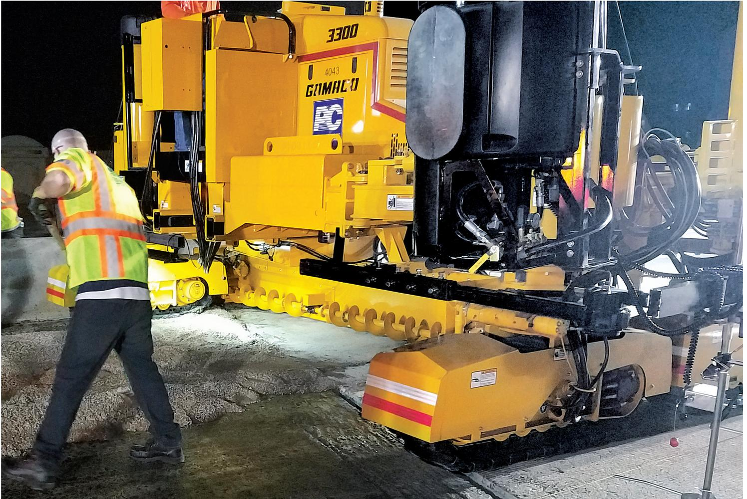
Ein GOMACO 3300 mit Spezialschalteil versieht eine Brücke mit einer 19 mm dicken Polymer-Hartbeschichtung.
