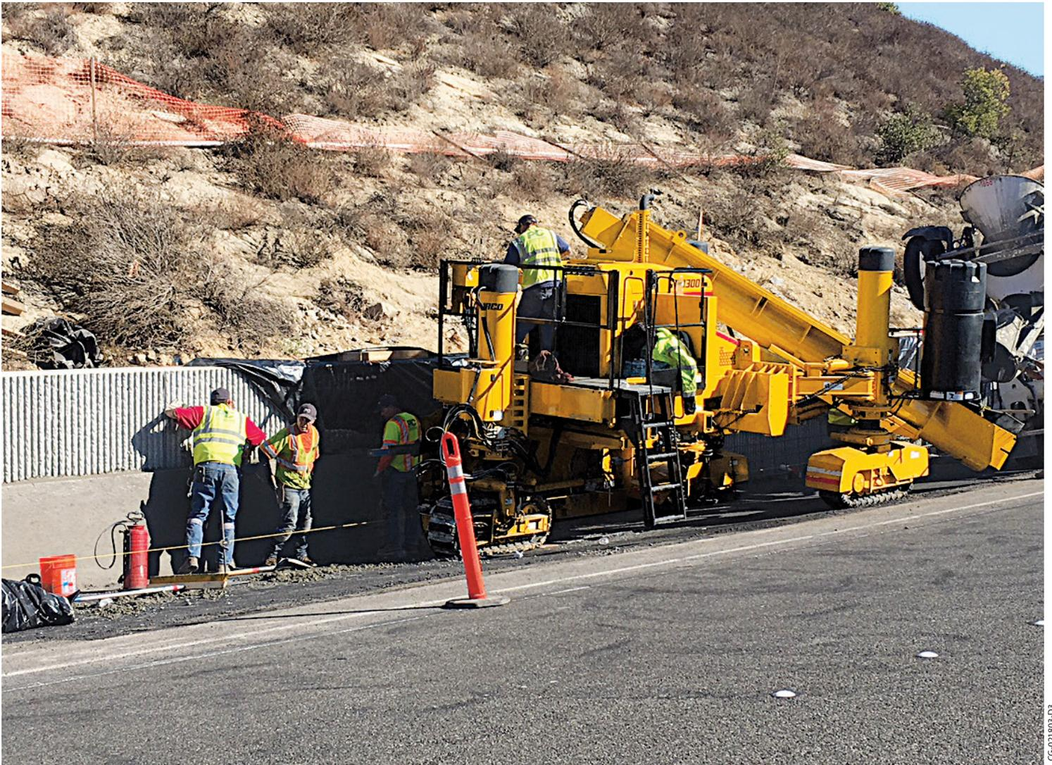
Dieser GOMACO 3300 fertigt auf der linken Seite der Maschine eine Brüstungsmauer.
