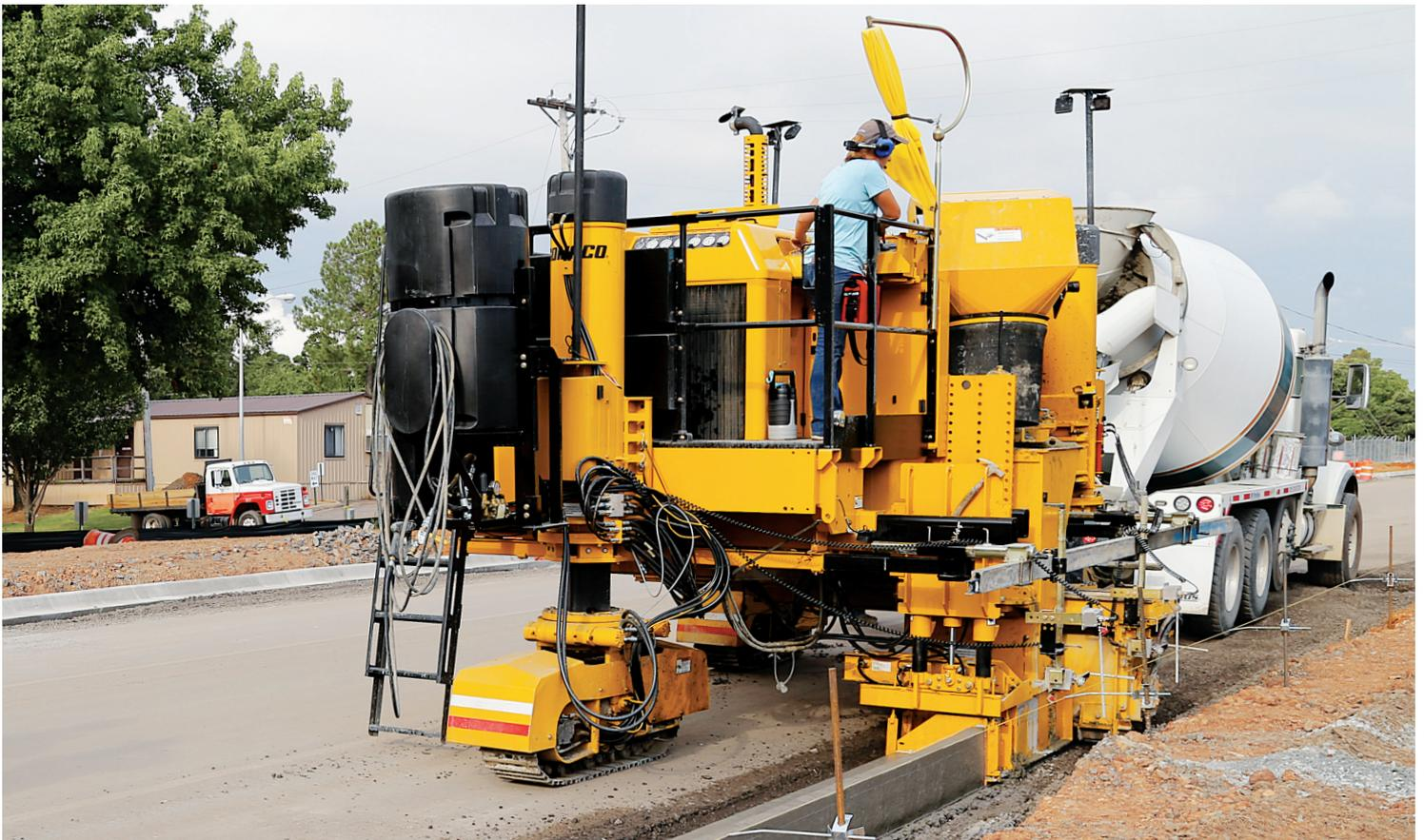
Bei Sanierungsprojekten können dank der hydraulischen Seitenverschub- und Hebefunktionen des 3300 mit dem Schalteil problemlos unterhalb der bestehenden Erdkante Bordkanten und Rinnsteine gefertigt werden.
