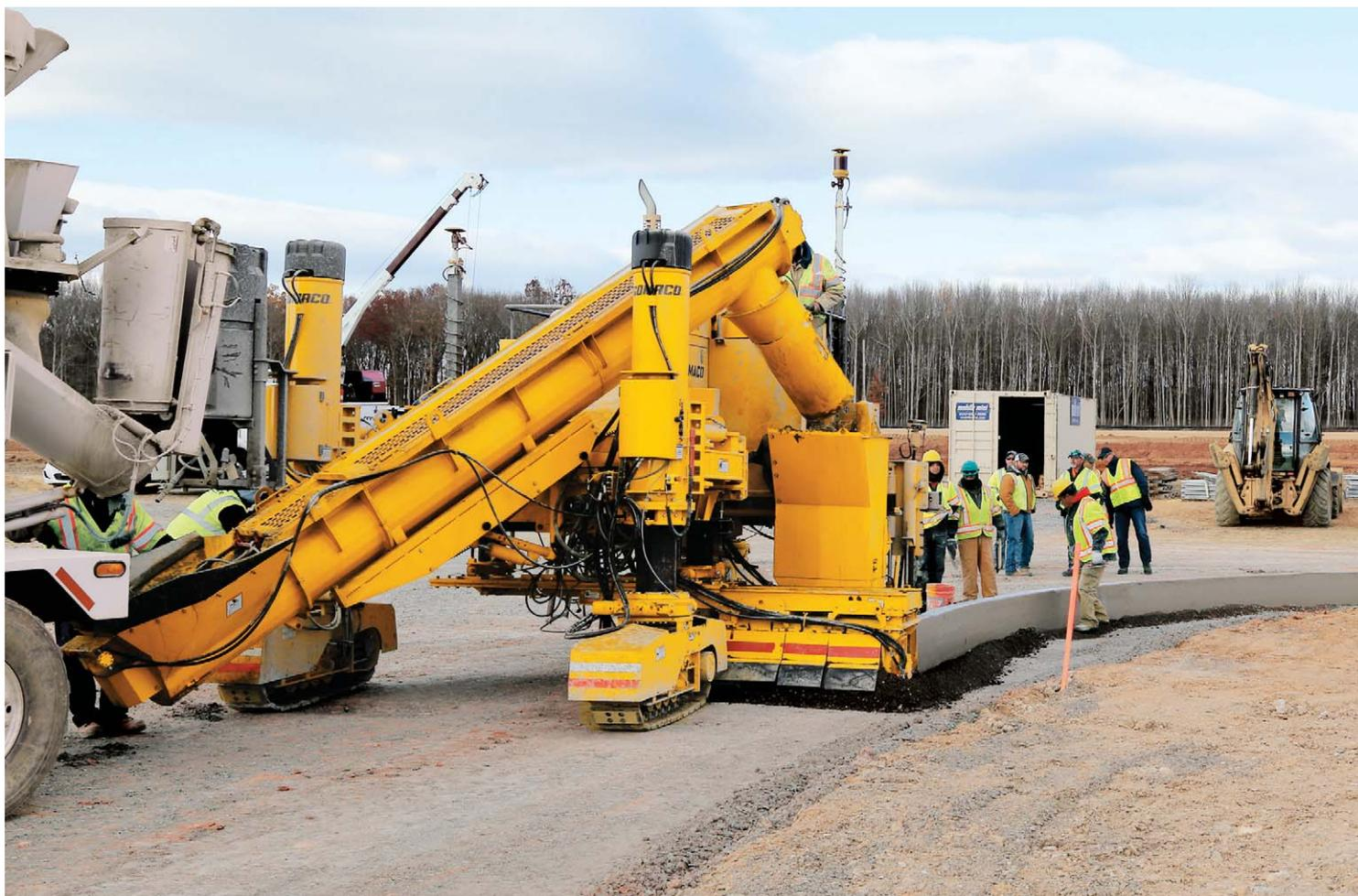
Cette GOMACO 3300 est équipée d'une fraise à déport latéral et d'un moule à bordures. Elle offre le système de montage de moule extensible intelligent avec retour d'information aux commandes G+® pour que le déport du moule soit reproductible. Le moule et la fraise peuvent être levés hydrauliquement par-dessus les obstacles rencontrés sur le chantier.
