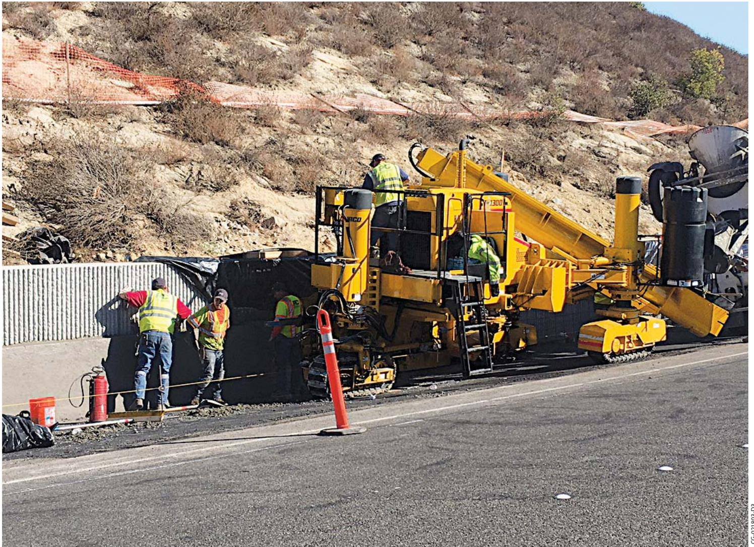
Cette GOMACO 3300 est en train de construire un mur de parapet à sa gauche.
