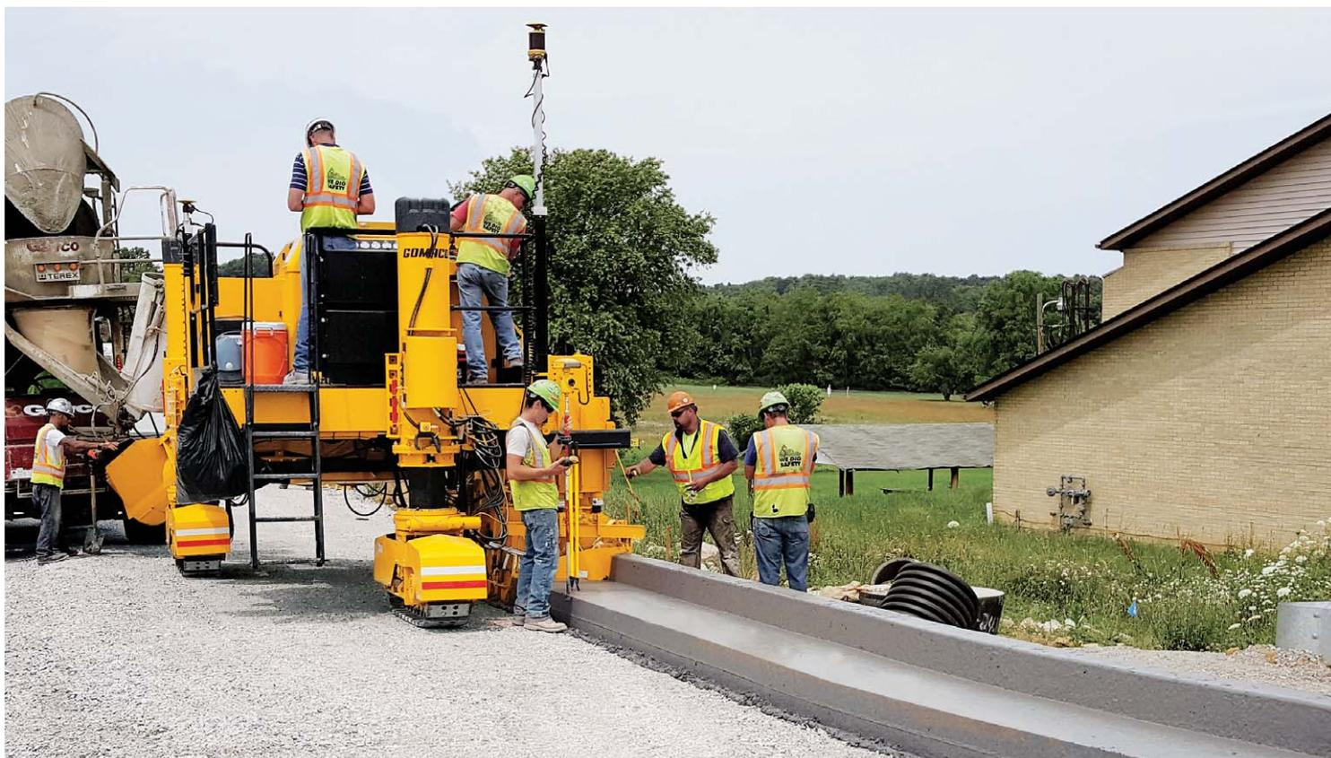
Une 3300 construit une bordure et un caniveau sur la droite avec un système de guidage 3D. Travailler dans le sens de la circulation est avantageux pour les entrepreneurs car les camions de béton peuvent rouler devant la bétonnière et reculer facilement pour déverser le béton sans perturber la circulation.
