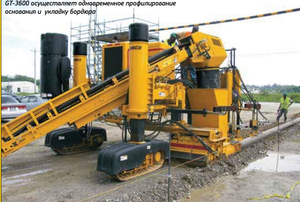
**Укладка бордюра и водоотводного лотка: проект обустройства парковки выполняется с использованием бесструнной системы нивелирования 3D.**
