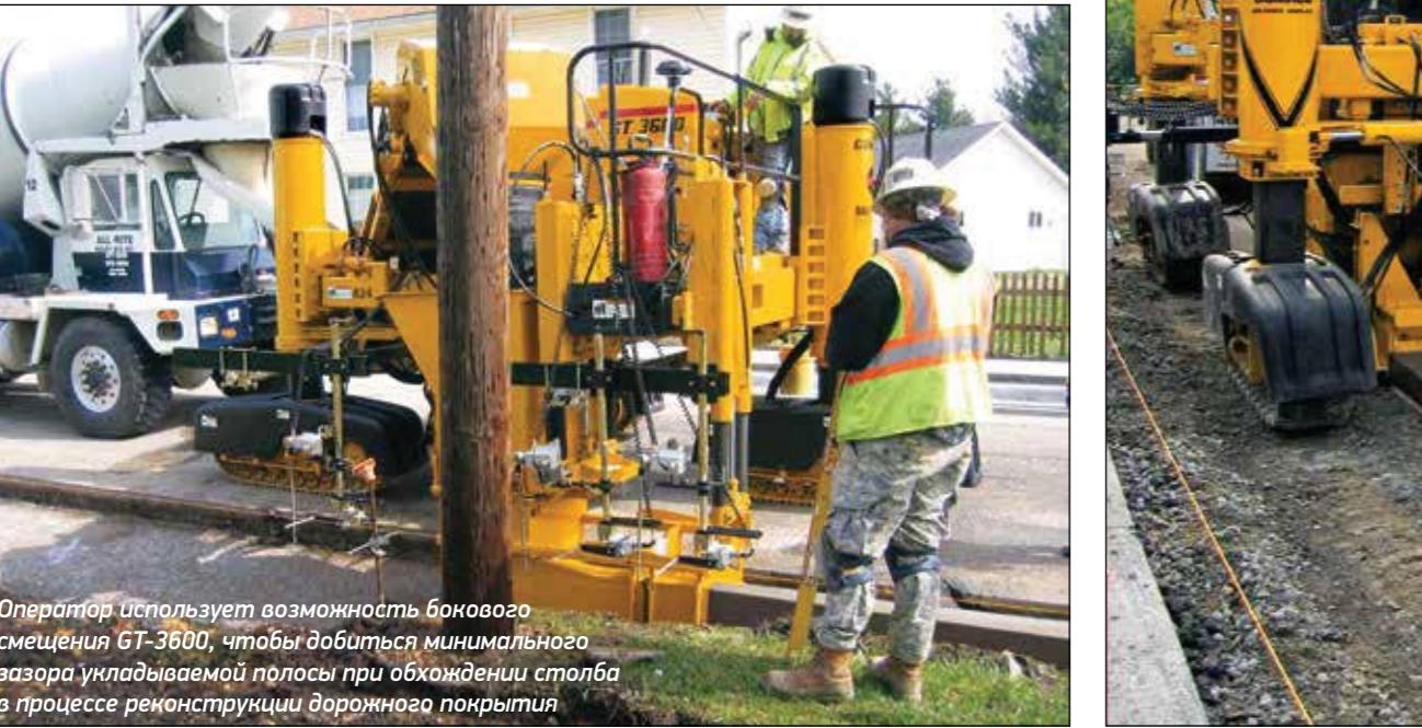
Оператор использует возможность бокового смещения GT-3600, чтобы добиться минимального зазора укладываемой полосы при обходжении столба в процессе реконструкции дорожного покрытия
