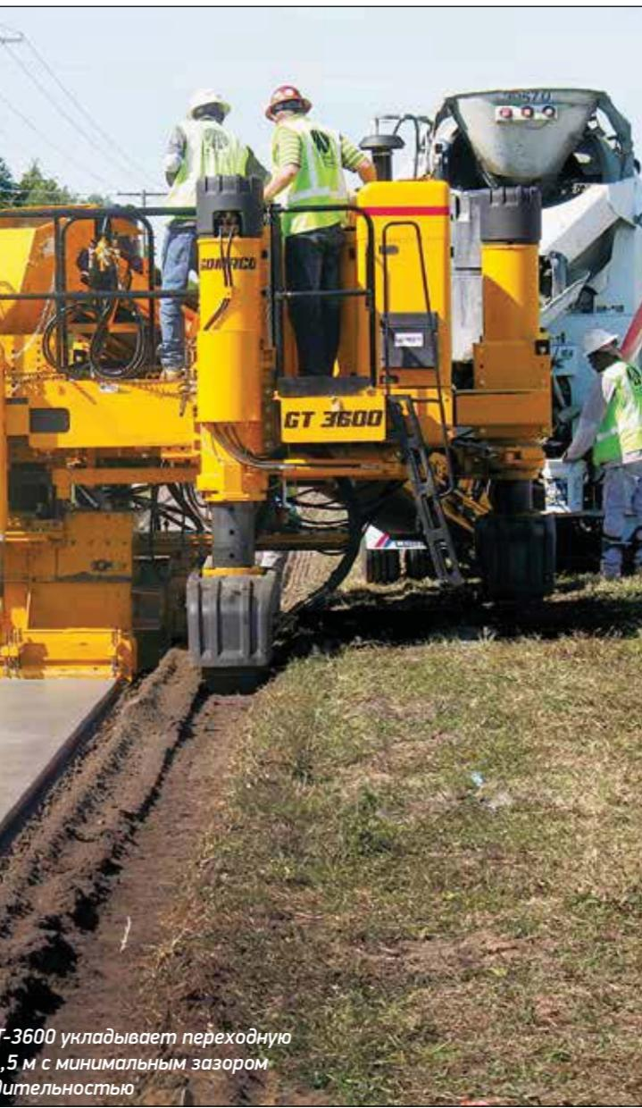
Бетоноукладчик GT-3600 укладывает бордюр и водоотводной лоток под наклоном на проекте по реконструкции дорожного покрытия. Использование функций телескопирования и прижатия формы позволяет бетоноукладчику обходить телефонные столбы с минимальным зазором укладываемого покрытия
