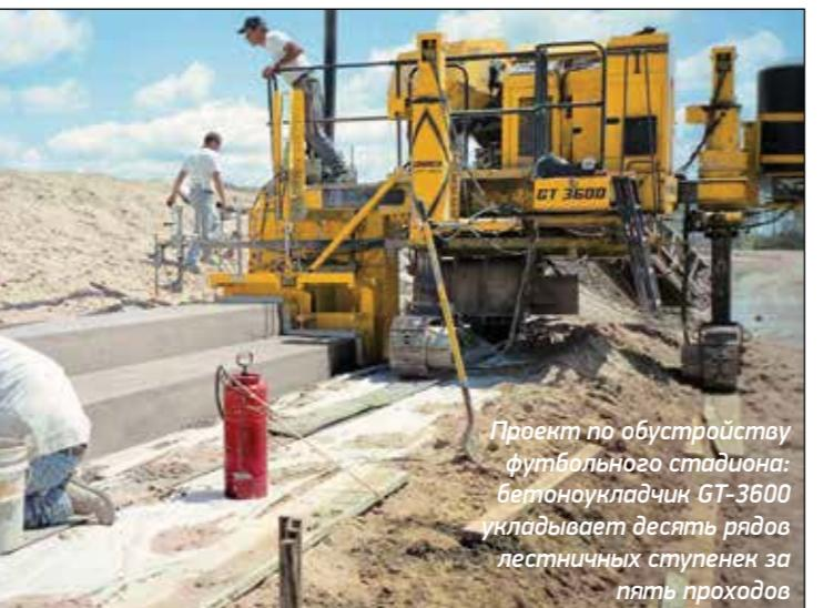
*Проект по обустройству футбольного стадиона: бетоноукладчик GT-3600 укладывает десять рядов лестничных ступенек за пять проходов*
