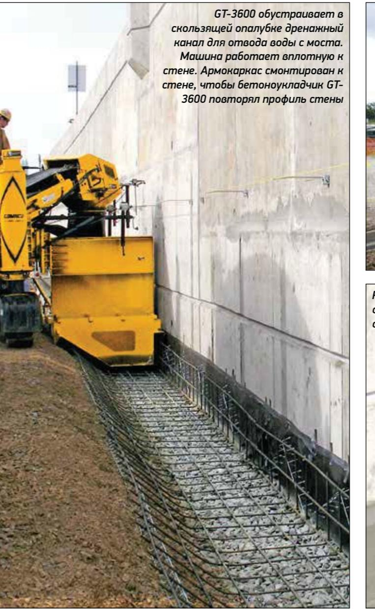
GT-3600 обустраивает в скользящей опалубке дренажный канал для отвода воды с моста. Машина работает вплотную к стене. Армокаркас смонтирован к стене, чтобы бетоноукладчик GT-3600 повторял профиль стены
