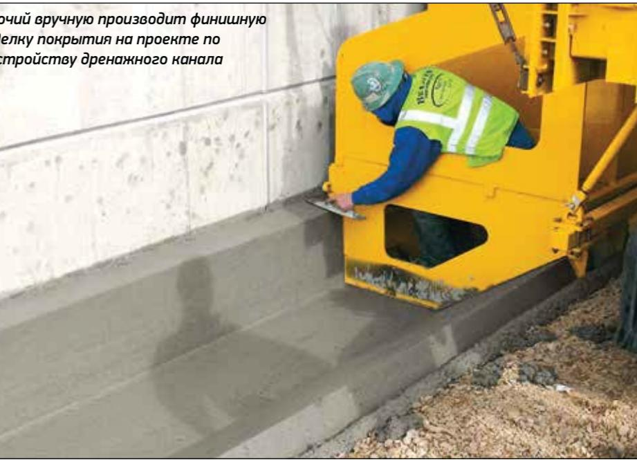
Рабочий вручную производит финишную отделку покрытия на проекте по обустройству дренажного канала
