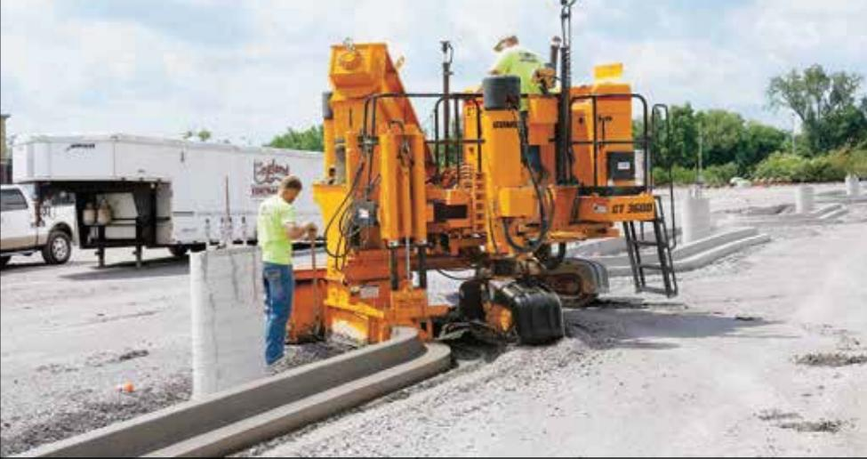
Ленточный бордюр, бордюр и водоотводной лоток, мостовой парапет, разделительный барьер, тротуар, парковая дорожка, Оросительные каналы и дренажные канавы Одновременное профилирование основания и укладка профиля. Минимальный зазор. Бетонирование поверх арматурного каркаса. Устройство профилей с продольным армированием.
