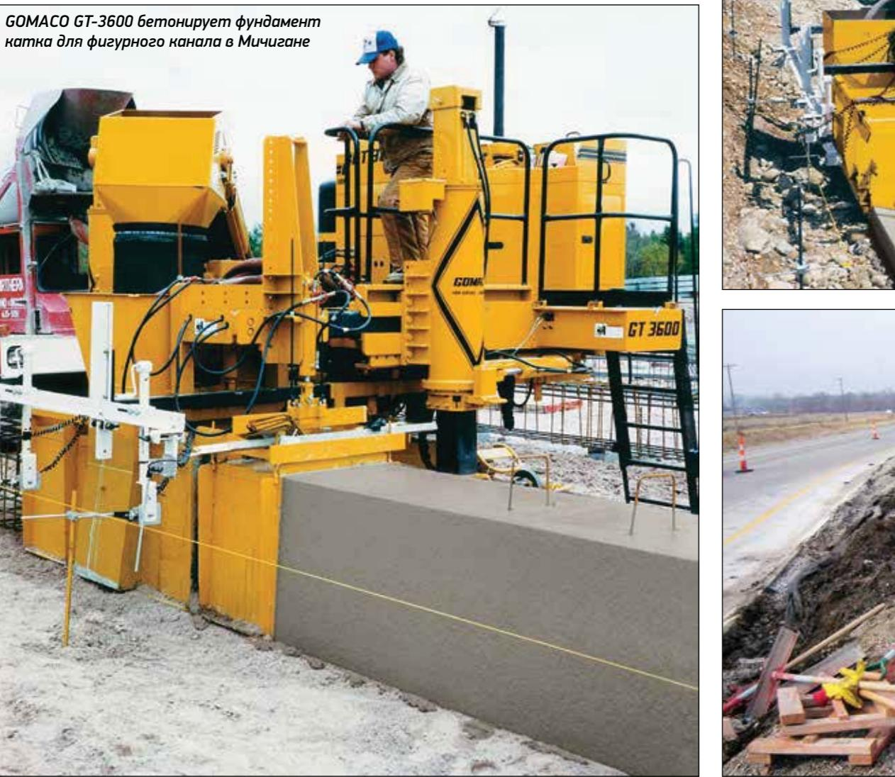
*GOMACO GT-3600 бетонирует фундамент катка для фигурного канала в Мичигане*
