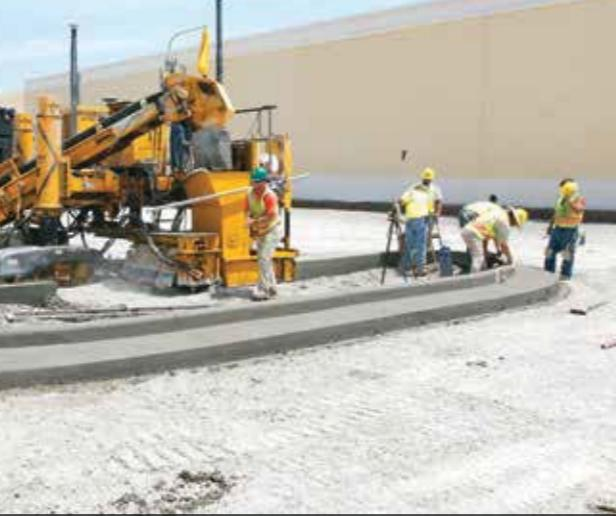
**16 малых парковочных зон и одна большая по центру были обустроены в первый день работы. Этот день также стал и первым днём работы подрядчика с системой нивелирования Topcon 3D, встроенной в систему управления GOMACO G+ бетоноукладчика GT-3600 для укладки бордюров и водоотводных лотков**
