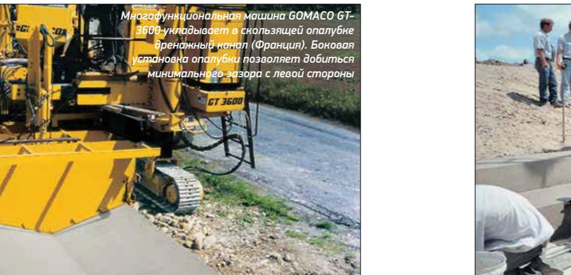
*Многофункциональная машина GOMACO GT-3600 укладывает в скользящей опалубке дренажный канал (Франция). Боковая установка опалубки позволяет добиться минимального зазора с левой стороны*
