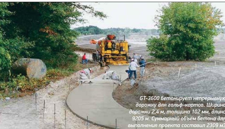
*GT-3600 бетонирует непрерывную дорожку для гольф-карт. Ширина дорожки 2,4 м, толщина 102 мм, длина 9205 м. Суммарный объём бетона для выполнения проекта составил 2309 м<sup>3</sup>*
