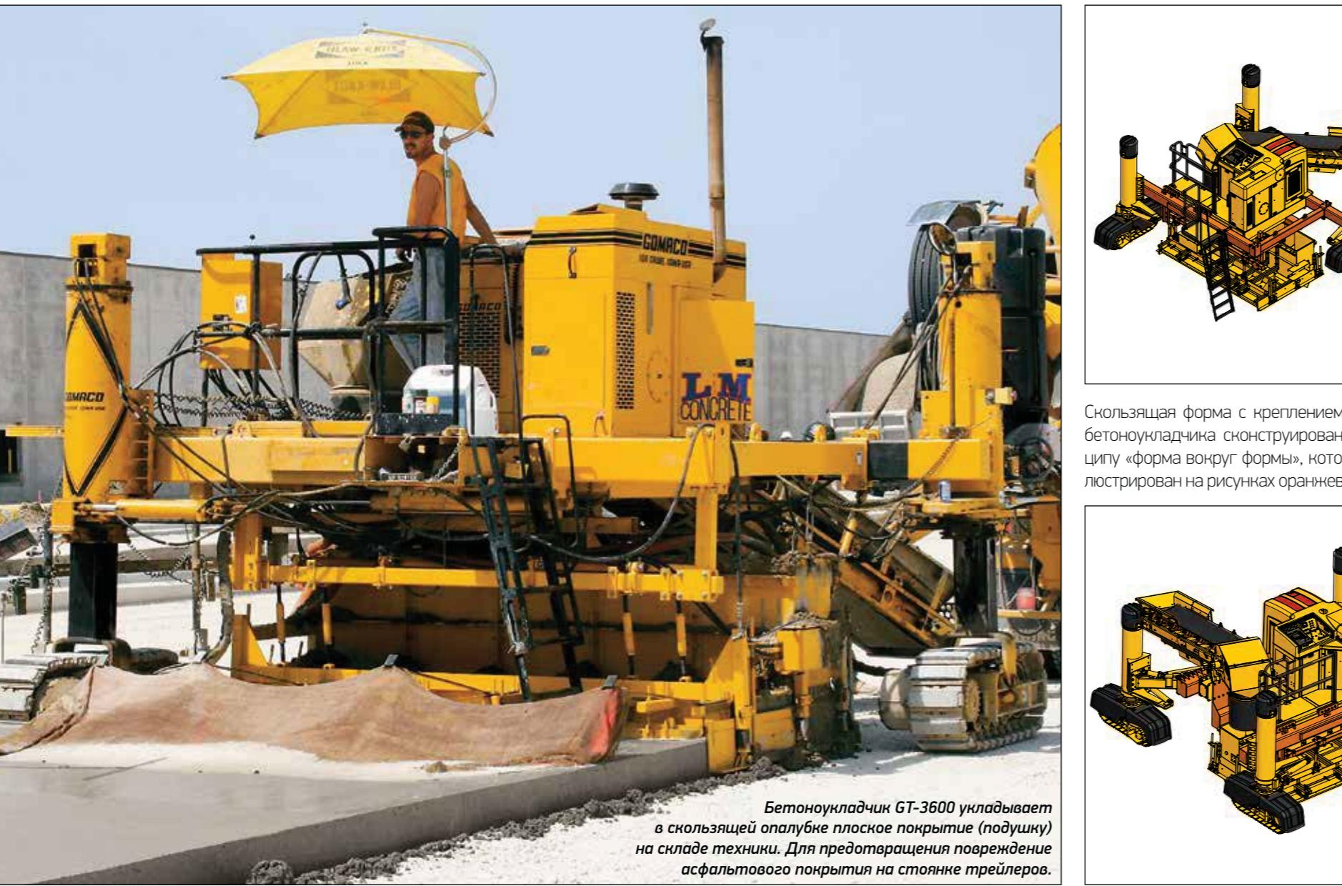
Бетоноукладчик GT-3600 укладывает в скользящей опалубке плоское покрытие (подушку) на складе техники. Для предотвращения повреждение асфальтового покрытия на стоянке трейлеров.
