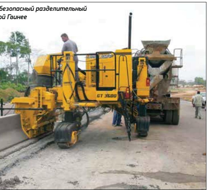
*GT-3600 укладывает в скользящей опалубке бордюр с водоотводным лотком на проезжей части (Канада)*
