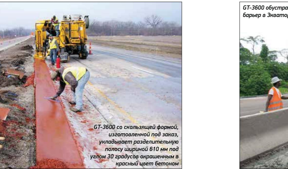
*GT-3600 со скользящей формой, изготовленной под заказ, укладывает разделительную полосу шириной 610 мм под углом 30 градусов окрашенным в красный цвет бетоном*
