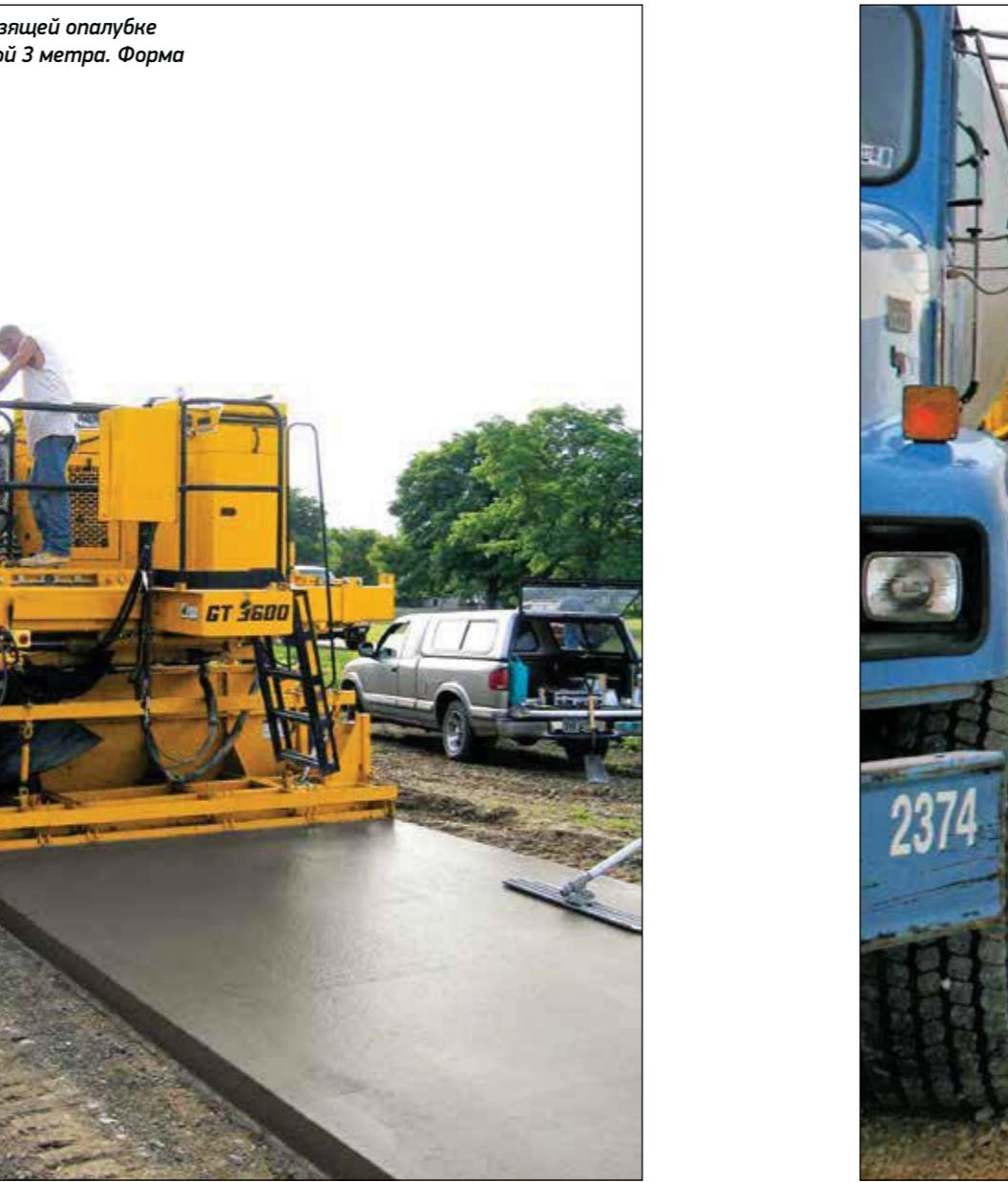
GT-3600 укладывает в скользящей опалубке пешеходную дорожку шириной 3 метра. Форма установлена по центру
