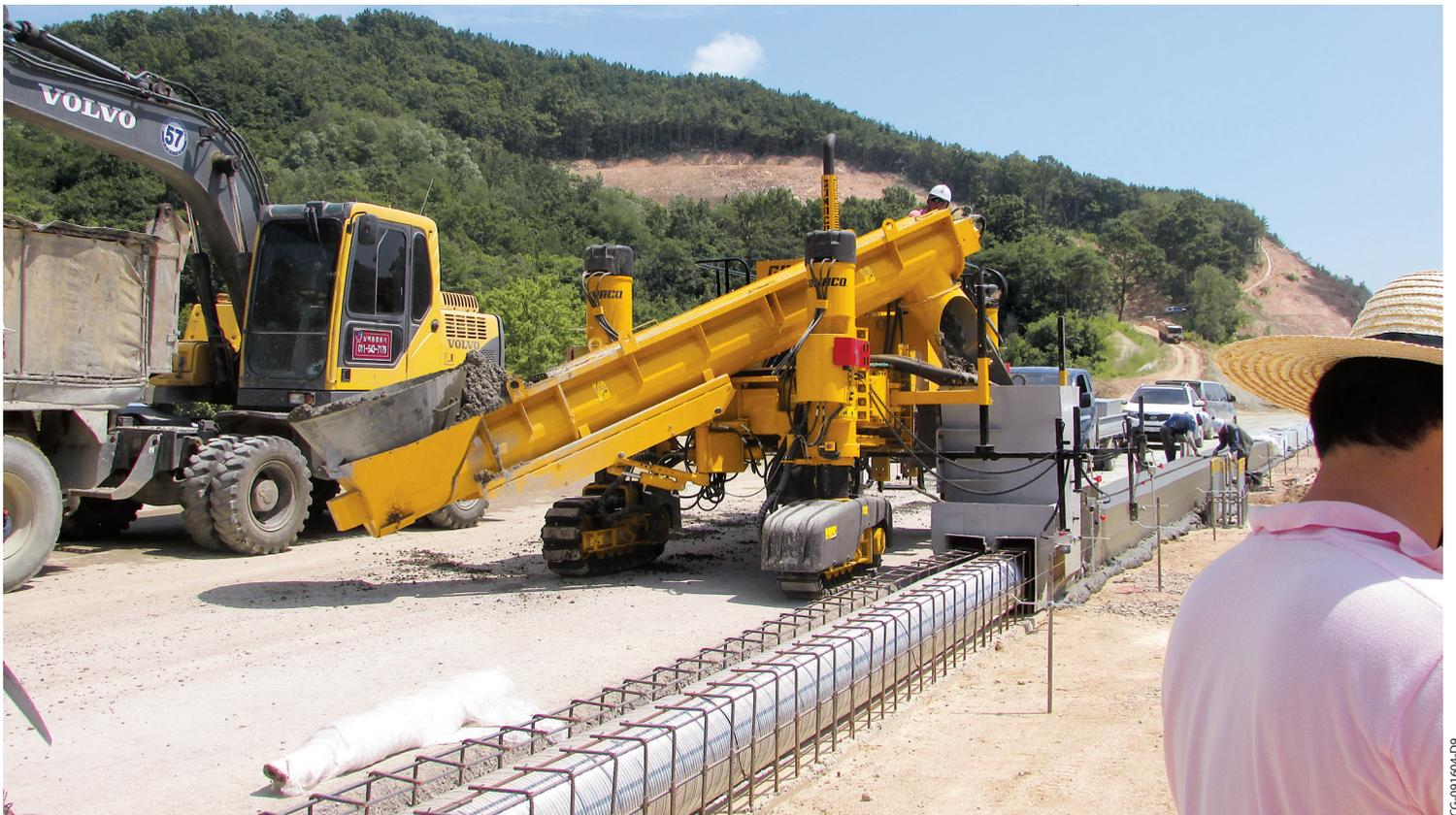
Der GOMACO 4400 fertigt einen neuen Schlitzablauf. Der 4400 verfügt an jedem Stützbein über eine GBox, die als neuer Anbringungsort für Slave-Steuerung und Proportionalventile dient, den Bedarf an Schläuchen und Kabeln verringert, die Wartung und Störungssuche erleichtert und über eine horizontale Schwingtür in Bodennähe bequem zu erreichen ist.
