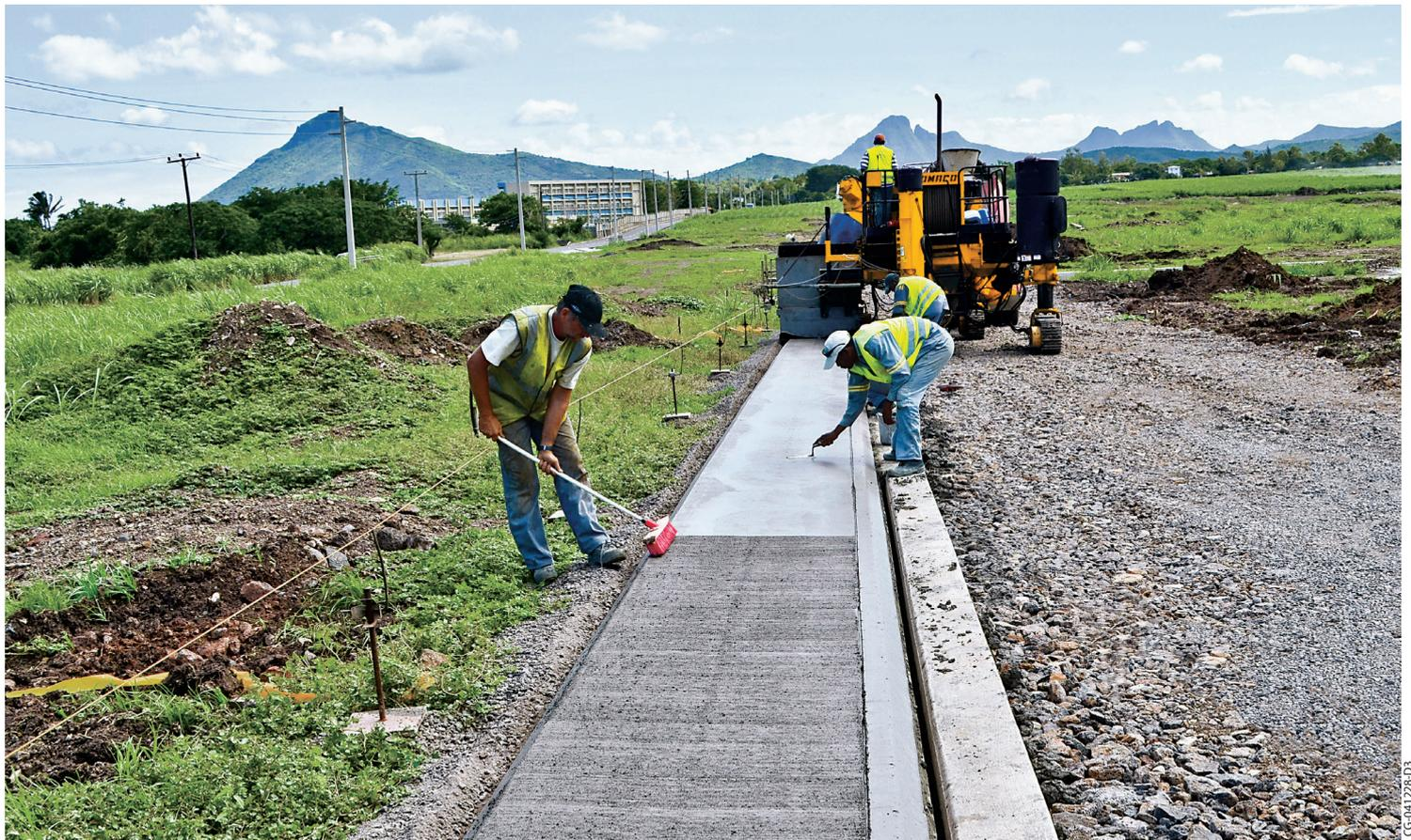
Der GOMACO 4400 betoniert einen Gehsteig, während Arbeitskräfte hinter der Maschine der Betonoberfläche mit dem Besen eine aufgeraute Struktur verleihen.
