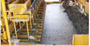
Las horquillas de inserción patentadas establecen la norma de la industria en cuanto a exactitud en la colocación de barras.
