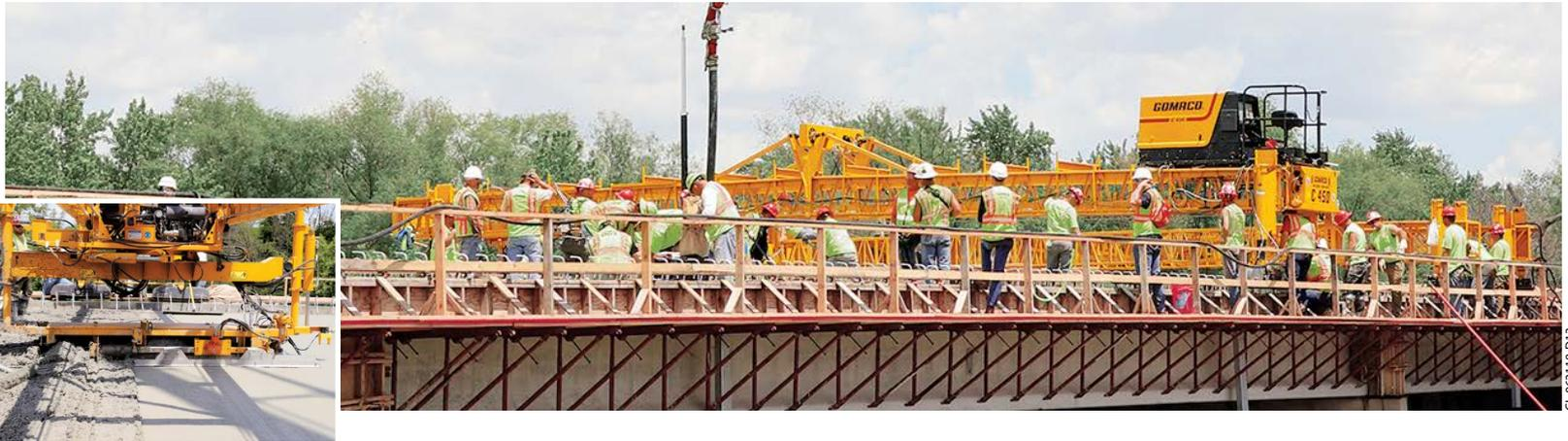
La poutre lisseuse haute production de GOMACO, en option, peut avancer jusqu'à 1,22 mètre en une seule passe pour réduire considérablement le temps de finition, ce qui permet d'économiser sur le coût de livraison du béton et sur la main-d'œuvre totale du projet.
