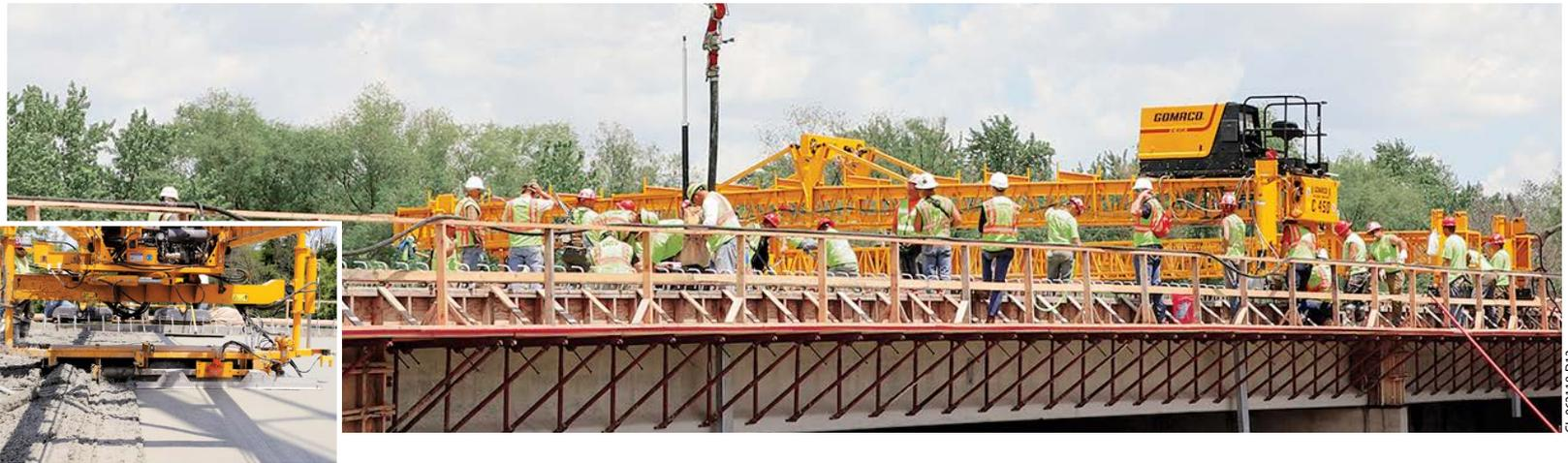
Der optionale GOMACO Hochleistungsabzieher kann in einem einzigen Arbeitsgang bis zu 1,22 Meter vorrücken und so die Endbearbeitungszeit drastisch reduzieren, was zu Einsparungen bei den Kosten für die Betonlieferung und den gesamten Arbeitsaufwand führt.
