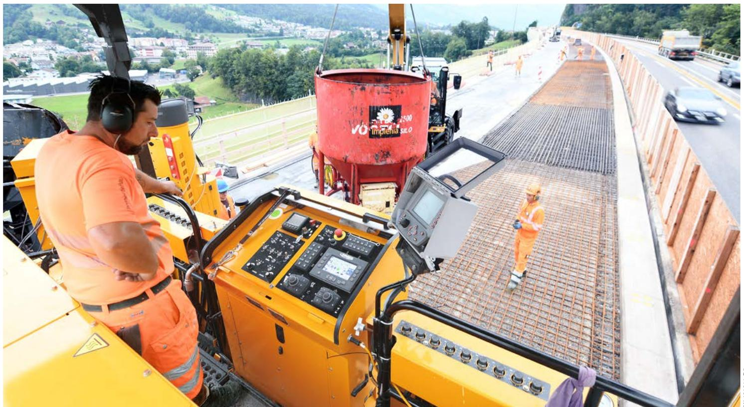
Der Gleitschalungsfertiger GP-2400 mit vier Raupen von GOMACO fertigt bei diesem Projekt in der Schweiz eine ultradünne Fahrbahndecke aus Beton („Whitetopping“). Dieser GP-2400 verfügt über die GOMACO-Ferndiagnostik (GRD), mittels der sich die Software aktualisieren lässt, ohne dass GOMACO-Mitarbeiter jemals das Werk in Ida Grove im US-Bundesstaat Iowa verlassen müssen.
