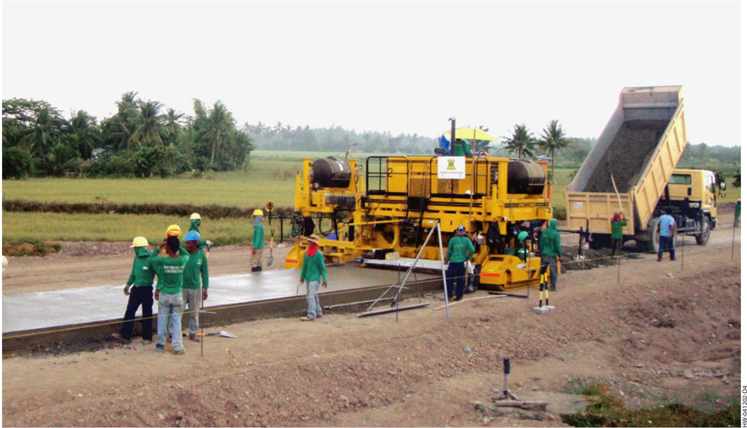
Der GOMACO GP-240 mit zwei Raupen fertigt einen sechs Kilometer langen Schnellstraßenabschnitt auf den Philippinen. Dieser Schnellstraßenabschnitt wird in einer Breite von dreieinhalb Metern und einer Dicke von 300 Millimetern ausgeführt.
