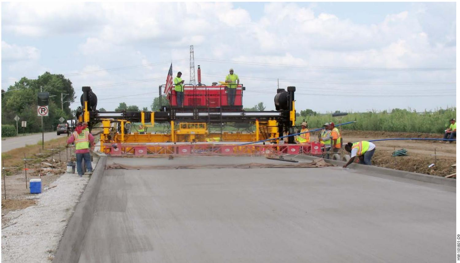
Der GOMACO GP-240 mit zwei Raupen fertigt eine 7,92 m breite, 254 mm dicke Landstraße mit integrierten Bordkanten auf beiden Seiten. Dieser Gleitschalungsfertiger verfügt über das nach vorne offene Schalteil der Serie 5000 mit einer Förderschnecke und einem Ankersetzgerät (TBI) der Serie 5400.
