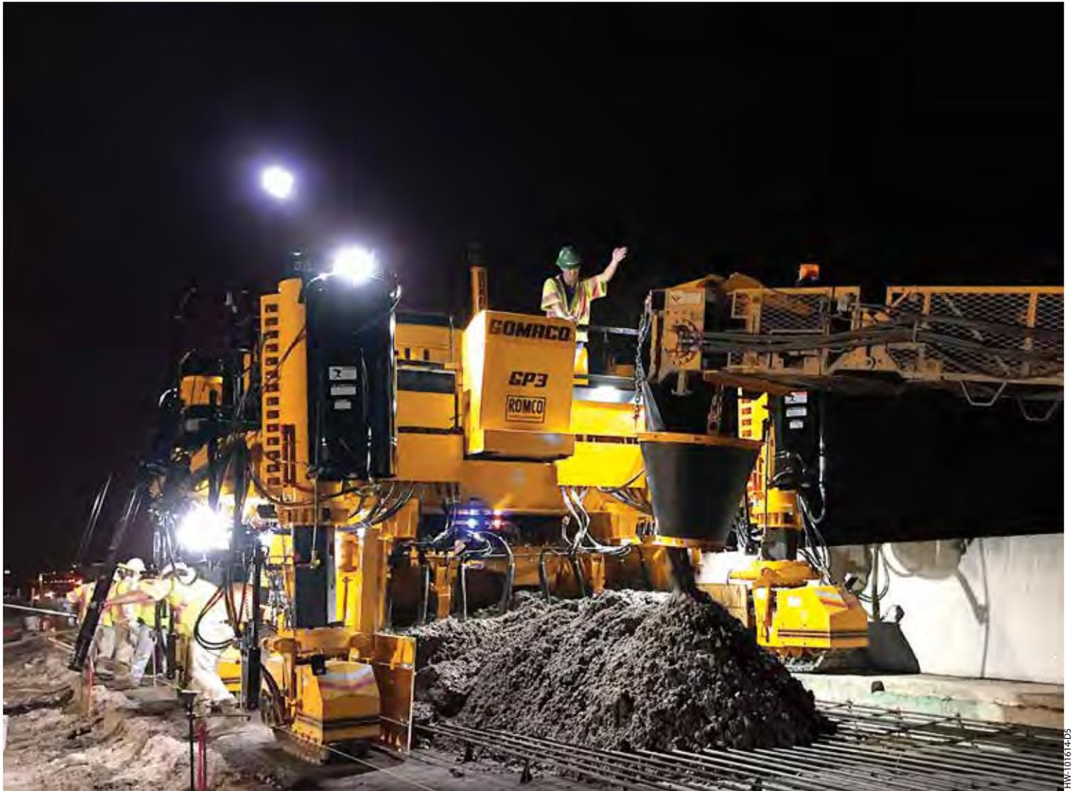
Der GP3 von GOMACO fertigt eine Fahrbahn, die für ein Autobahnprojekt über Nacht auf einer kontinuierlichen Stahlbewehrung aufbetoniert wurde. Ein RTP-500 von GOMACO setzt den Beton vor dem GP3 ab.
