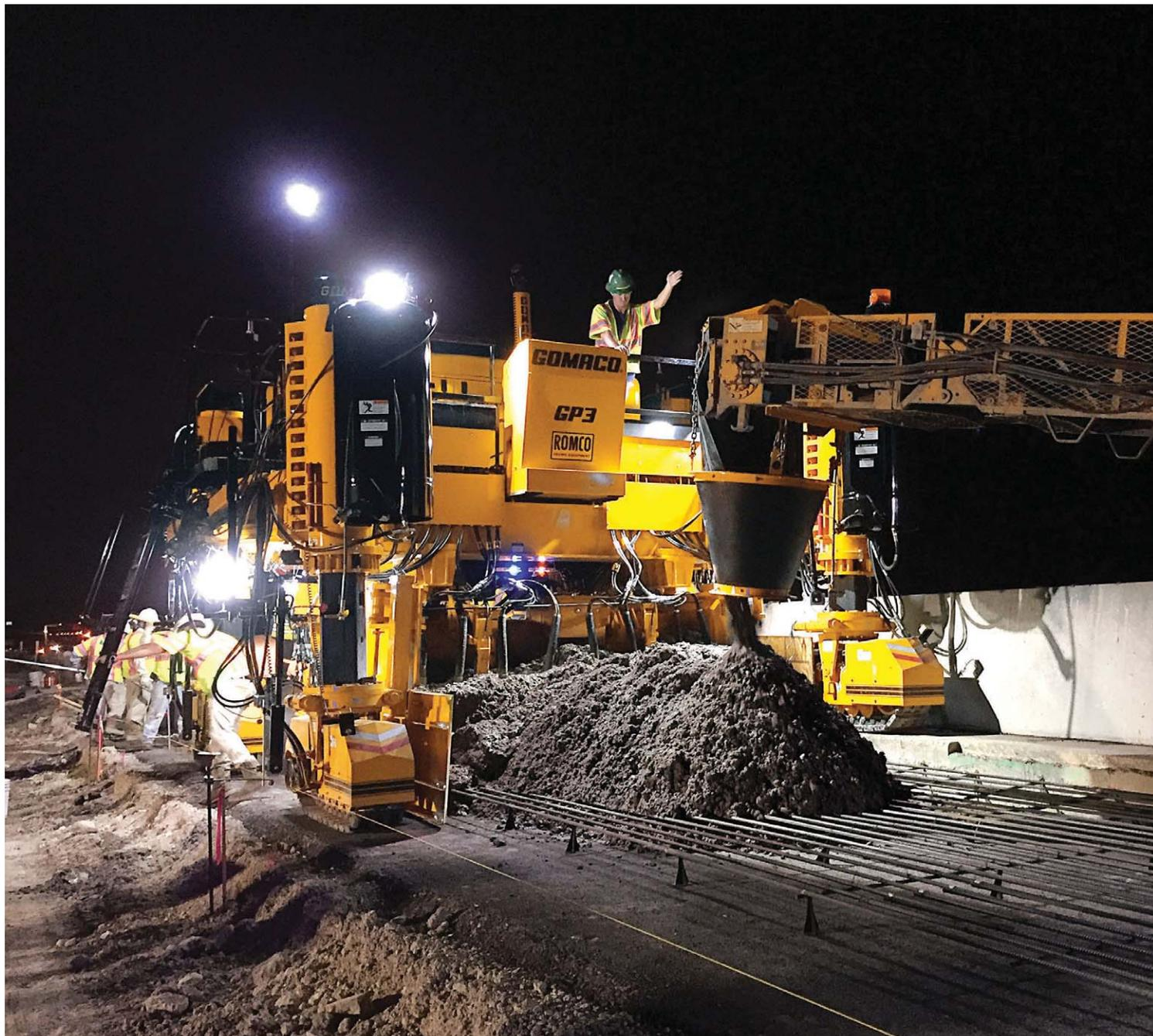
La GOMACO GP3 construit de nuit une voie surélevée sur des armatures continues en acier d'un chantier d'autoroute. Une GOMACO RTP-500 place le béton devant la GP3 depuis l'autre côté de la barrière.
