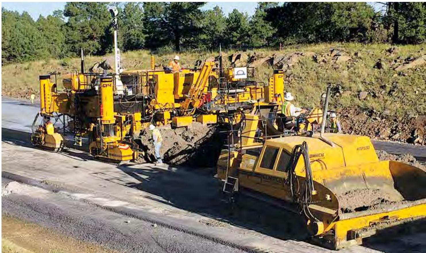
Der GOMACO GP4 fertigt mithilfe der 3D-Maschinenführung einen 7,32 m breiten Autobahnabschnitt. Der GOMACO RTP-500 setzt den Beton vor dem Fertiger ab.
