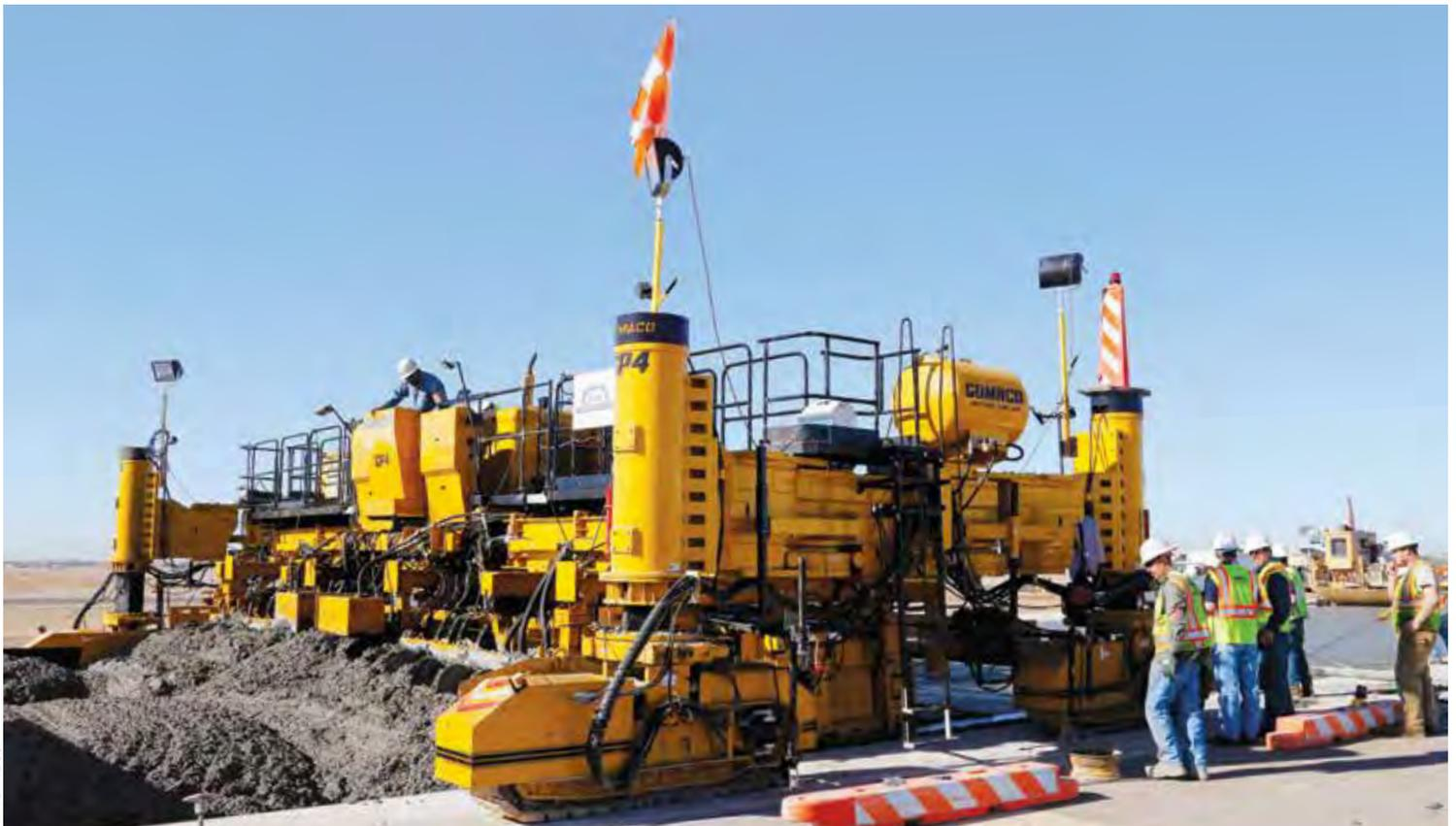
Der GOMACO-Fertiger GP4 fertigt eine neue Start- und Landebahn mit einer Breite von 11,43 Metern und einer Dicke von 483 Millimetern. Dieser GP4 verfügt über die GOMACO-Ferndiagnostik (GRD), die dem Maschinenpersonal die Möglichkeit gibt, direkt mit den Servicetechnikern in Ida Grove (Iowa) zu kommunizieren, um so Störungen zu beheben oder die Maschinensoftware zu aktualisieren.
