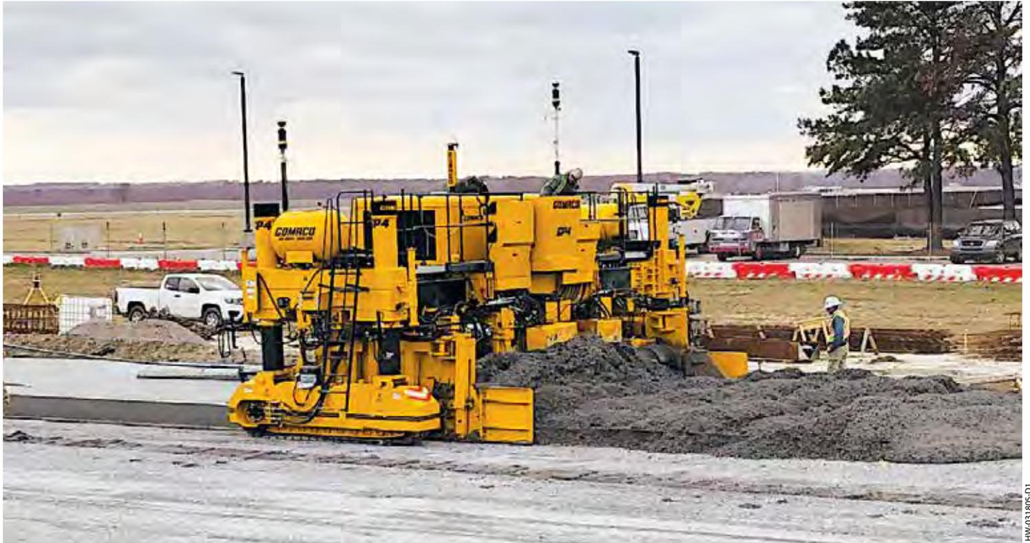
Der GOMACO-Fertiger GP4 mit zwei Raupen und 3D-Maschinenführung fertigt eine 7,62 m breite und 559 mm dicke Flughafenrollbahn.
