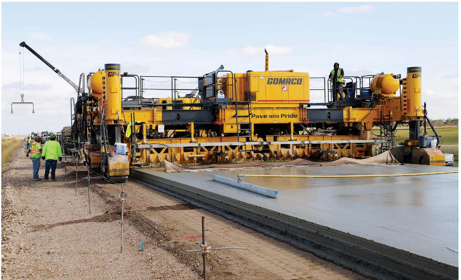
La machine à coffrage glissant GP4 à quatre chenilles de GOMACO pave l'autoroute avec un moule ouvert de la série 5400 et un indicateur de lissage GSI pour contrôler la régularité pendant l'opération de coulage.
