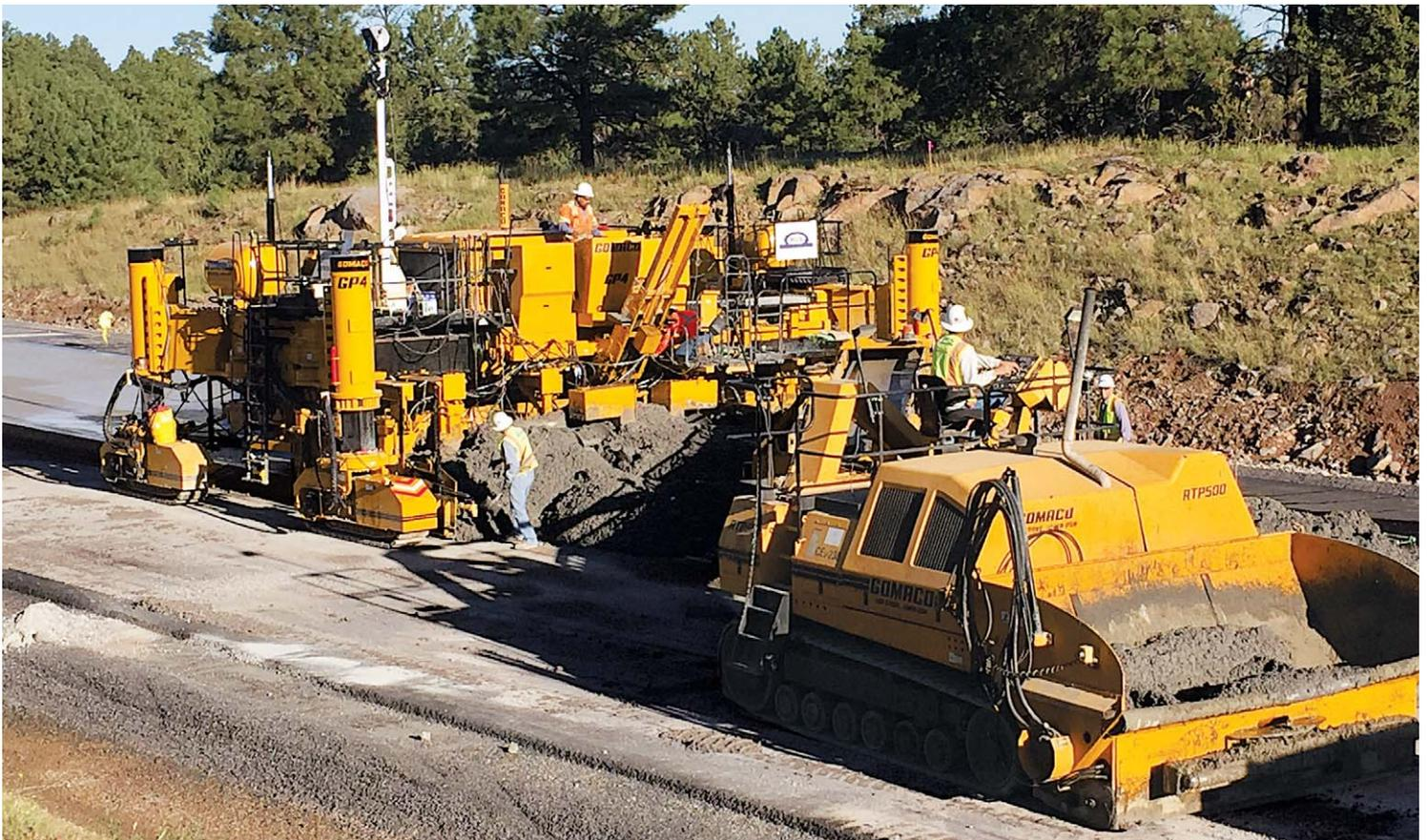
La GOMACO GP4 construit une section d'autoroute de 7,32 mètres de large à l'aide d'un système de guidage 3D. La GOMACO RTP-500 avance devant la GP4 pour placer le béton.
