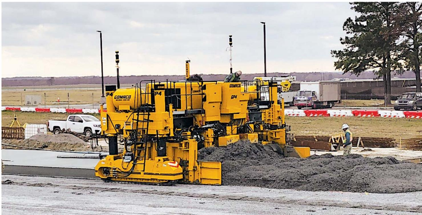
Cette bétonnière GOMACO GP4 deux chenilles avec guidage 3D de la machine construit une voie de circulation d'aéroport de 7,62 m de large et 559 mm d'épaisseur.
