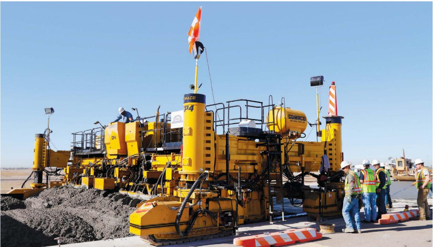
La bétonnière GOMACO GP4 construit une nouvelle piste de 11,43 mètres de large et de 483 millimètres d'épaisseur. Cette GP4 est équipée des diagnostics à distance GOMACO (GRD) qui permettent à ses utilisateurs de communiquer directement avec les techniciens du service après-vente à Ida Grove, dans l'Iowa (États-Unis), pour se faire dépanner ou obtenir des mises à jour de logiciels pour la machine.
