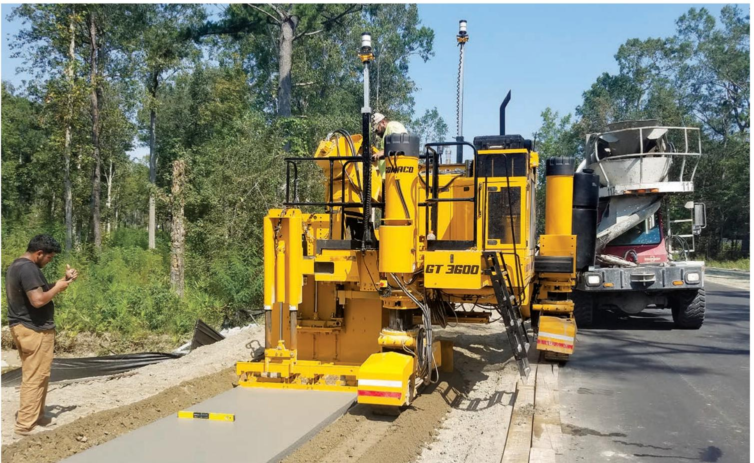
Der GOMACO Xtreme GT-3600 fertigt mithilfe der 3D-Maschinenführung einen 1,52 m breiten Gehsteig.
