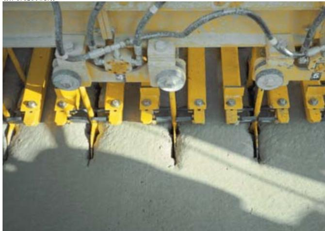
Вибрация передается на вилочные захваты при погружении стержней и служит для уплотнения бетонной смеси вокруг вставленных стержней. Нет необходимости останавливать бетоноукладчик для погружения арматурных стержней. Эксклюзивная технология «интеллектуальных» гидроцилиндров с компьютерным управлением компании GOMACO представляет собой современную систему для обеспечения заданной глубины погружения стержней в основание.
