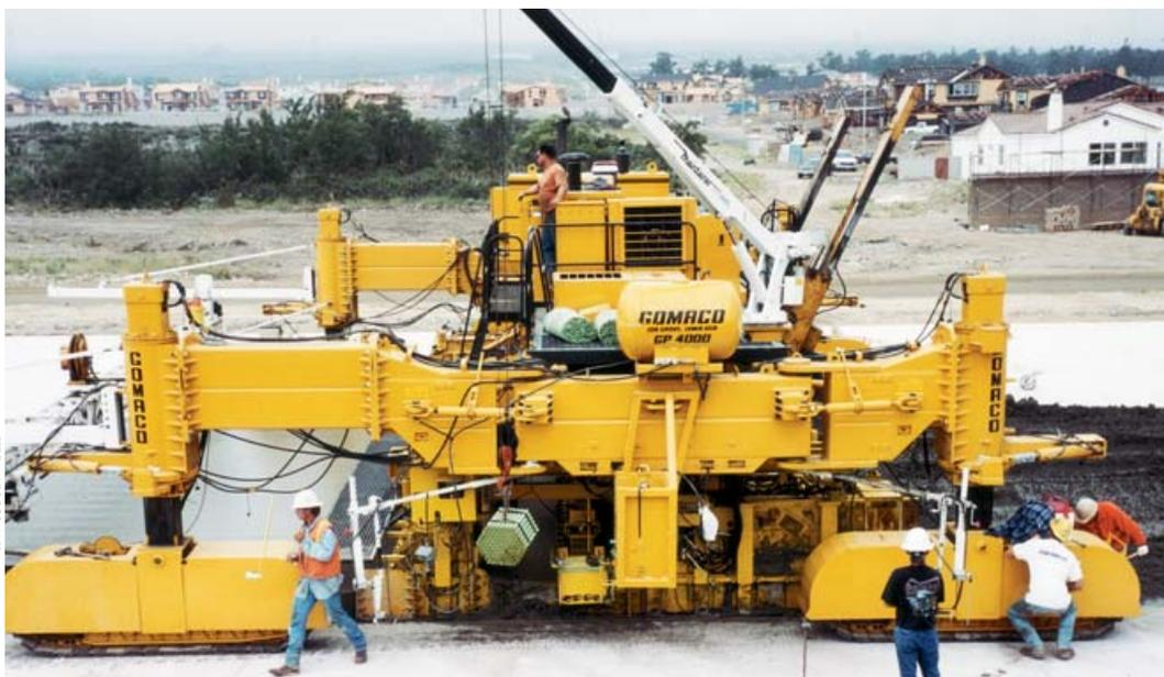
При реализации этого проекта главной магистрали укладка бетонной смеси на ширину 11,73 м осуществлялась с помощью четырехгусеничного бетоноукладчика
