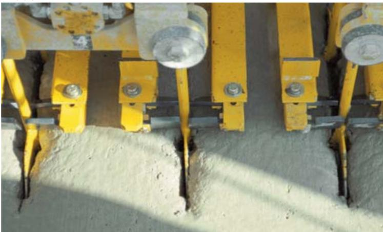
Вилочные захваты для погружения арматурных стержней запатентованной конструкции обеспечивают точность размещения в соответствии с отраслевыми стандартами. Вилочные захваты уменьшают количество задиrow при погружении, а вибрация улучшает процесс затвердевания материала вокруг стержней.
