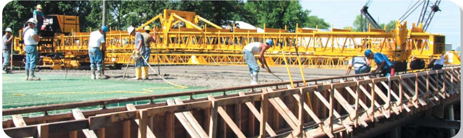
При бетонировании проезжей части моста в Миннесоте подрядчик оборудовал свой финишер нового поколения С-450 вальцевым рабочим органом, виброплощадкой, винтовыми рабочими органами и выглаживающей плитой с мешковиной.
