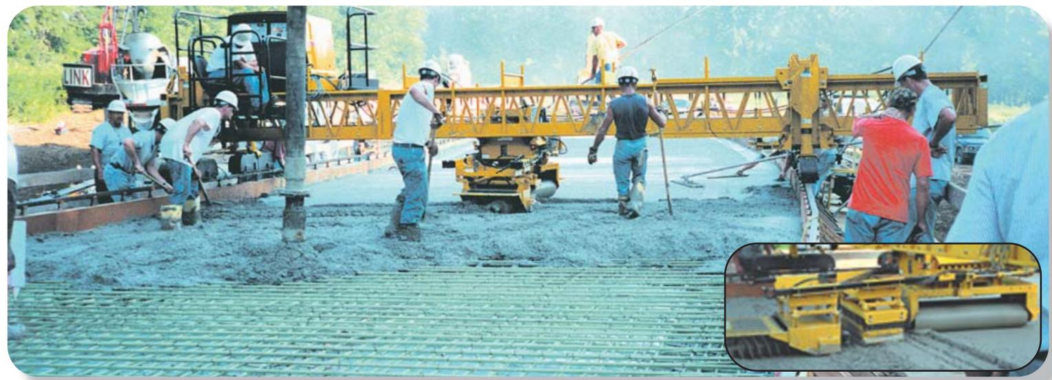
Финишер нового поколения С-450 обеспечивает высокую производительность работ по окончательной отделке бетонного покрытия этого моста в Индиане. Подрядчик оборудовал финишер С-450 двухвальцевым рабочим органом, виброплощадкой и винтовыми рабочими органами для быстрой и высококачественной отделки поверхности покрытия различного профиля.
