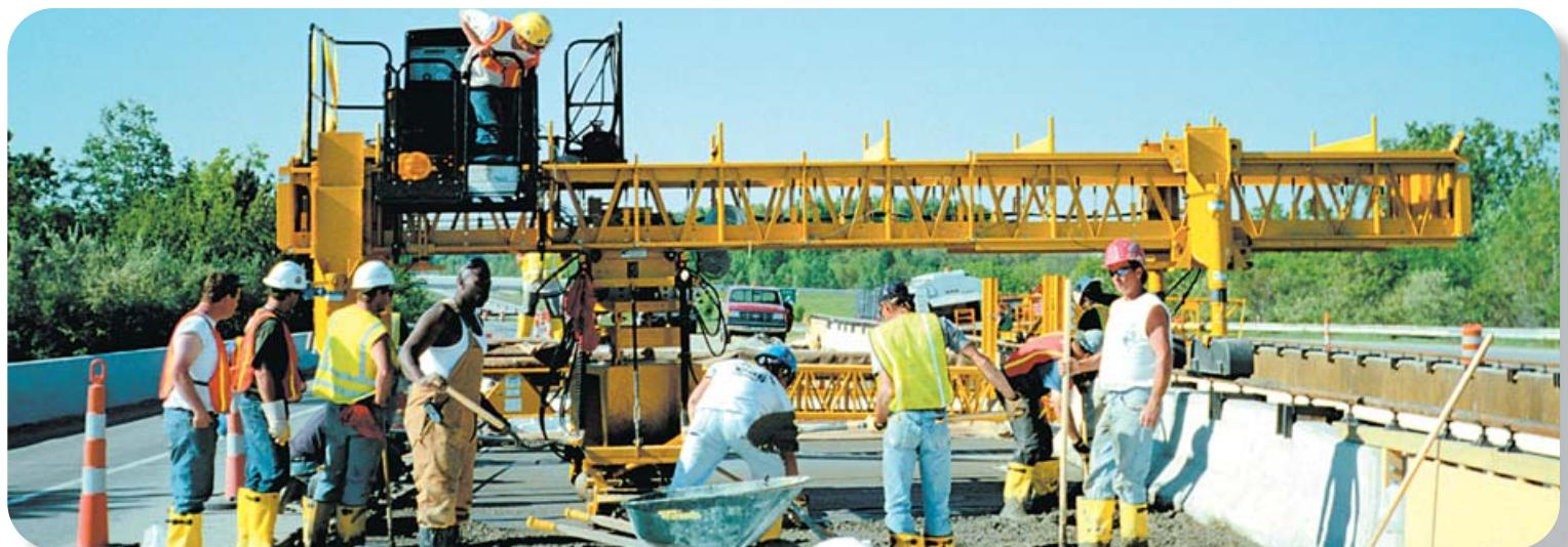
Финишер нового поколения С-450 оборудован уникальным двухвальцевым рабочим органом, виброплощадкой и винтовыми рабочими органами. Эта машина позволяет выглаживать с высоким качеством поверхность покрытия на обеих сторонах, выглаживать поверхность свежеуложенного разделительного барьера, что снижает до минимума ручные выглаживающие работы.
