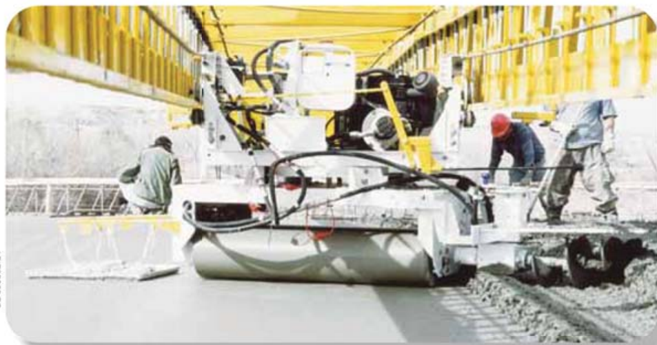
Запатентованная GOMACO система укладки "3-Point"
