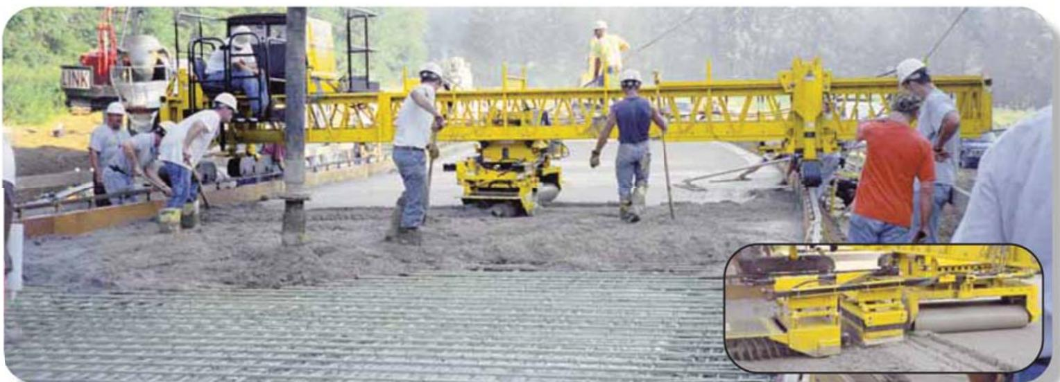
Финишер С-450 с высокой производительностью укладывает покрытие на этом мостовом настиле в Индиане. Подрядчик оборудовал свою модель С-450 двойным цилиндром, регулируемым поверхностным поддонным вибратором и регулируемыми фрезами, что позволяет быстро, легко и точно регулировать уклон.
