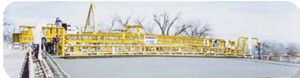
Финишер GOMACO C-450 укладывает мостовой настил шириной 72 фута (21,95 м) в Нью-Мексико. Рабочий орган финишера оборудован двойным цилиндром с регулируемыми фрезами. Разработанный корпорацией GOMACO рабочий мост Spanit® серии 4000 следует за C-450 при любых окончательных отделочных работах. Уникальная конфигурация моста Spanit® обеспечивает плотное прилегание к настилу.
