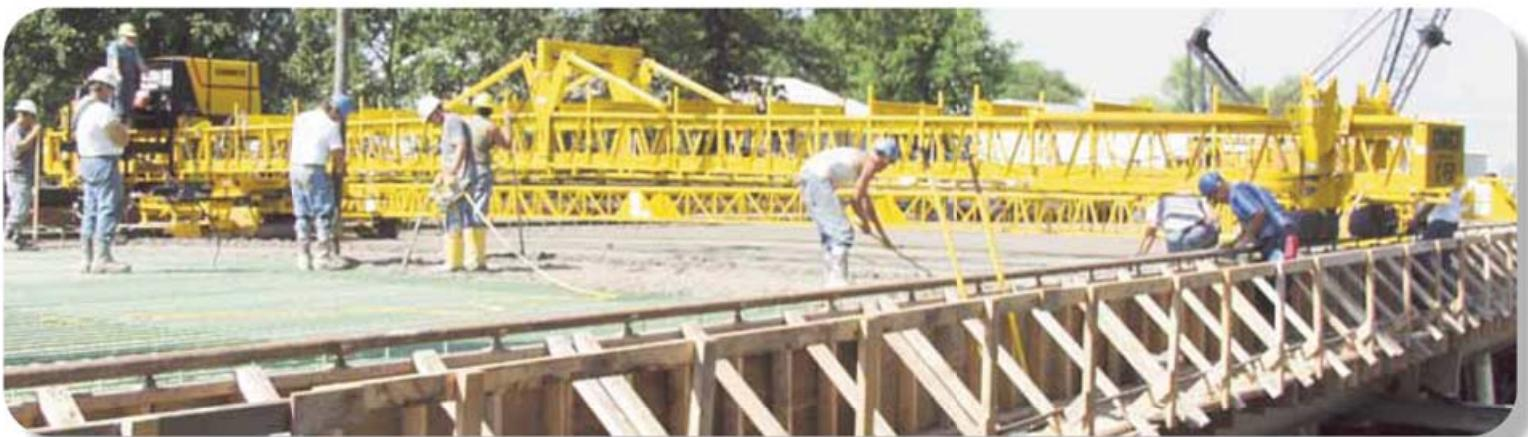
Для работы на этом мосту в Миннесоте подрядчик оборудовал свой С-450 рабочим органом с двойным цилиндром, регулируемым поверхностным поддонным вибратором, регулируемыми фрезами и регулируемым плавающим поддоном с приспособлениями для разутюживания покрытия.
