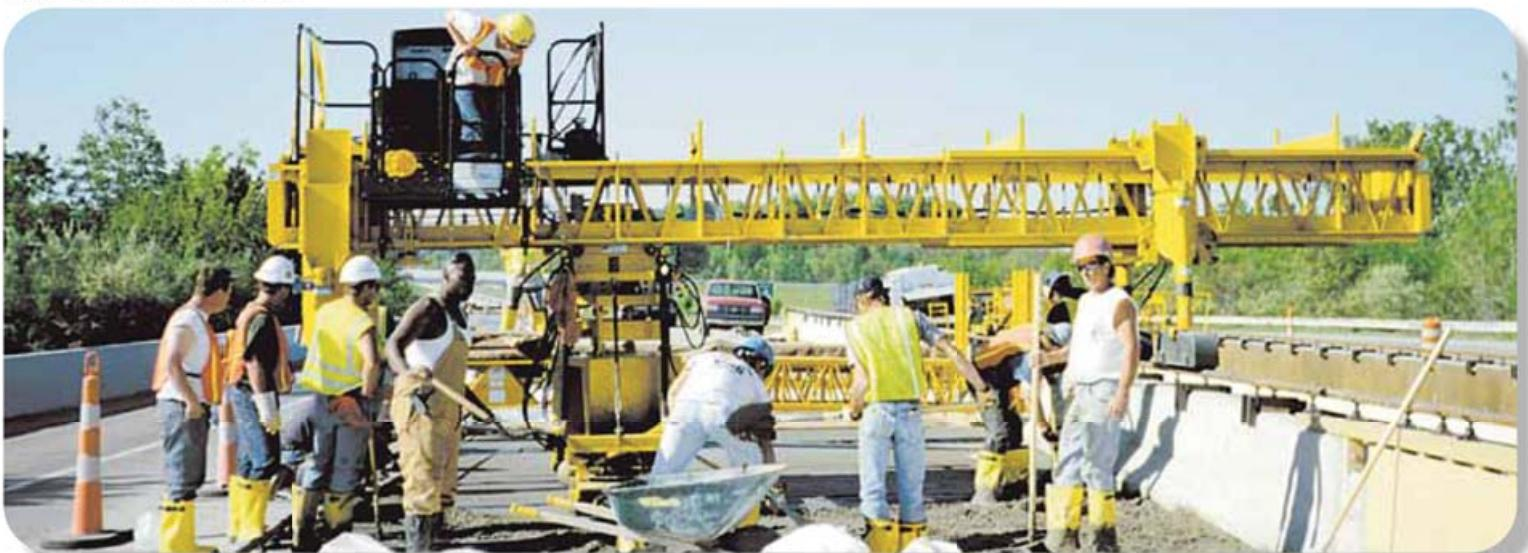
Этот финишер С-450 имеет уникальную расширенную ходовую часть с двойным цилиндром и оборудован регулируемым поверхностным поддонным вибратором и регулируемыми фрезами. Эта машина универсальна, потому что может двигаться с катками на уклоне на одной стороне и на другой стороне, сейчас она работает наверху разделительной стены. Это сводит к минимуму ручные работы и обеспечивает однородность отделки в условиях, когда зазоры минимальны.
