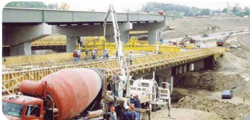
Финишер C-450, работающий на этом мостовом настиле, оборудован двумя регуляторами перемещения усилия (PTA), установленными в местах штифтовых соединений для изменения высоты гребня “на ходу”
