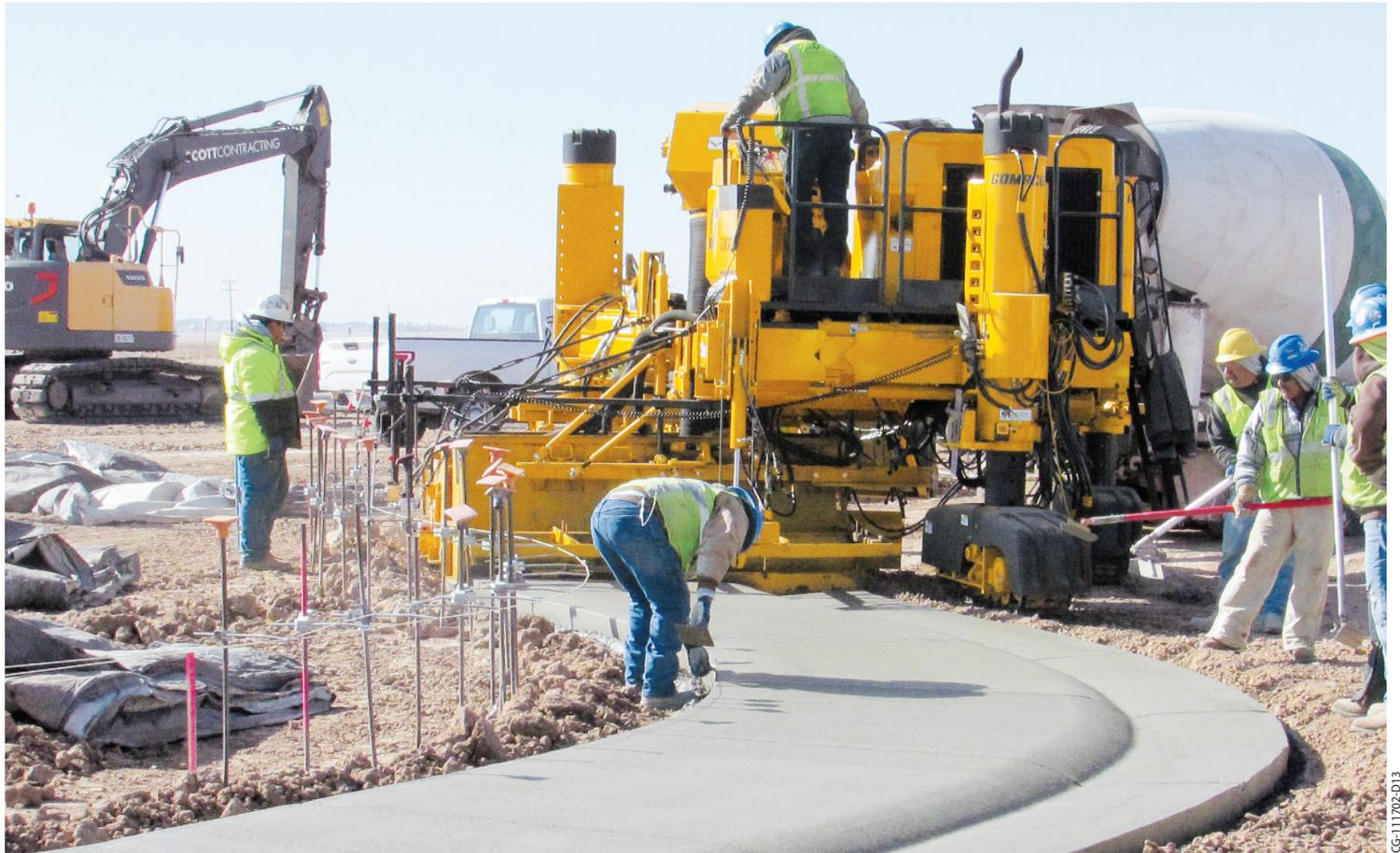
Der GOMACO Commander III mit drei Raupen fertigt die Bordkante und den Rinnstein eines monolithischen Gehsteiges. Der Commander III ist mit einem schwenkbaren Bedienpult ausgestattet, von dem aus der Bediener aktiv eingreifen kann und freie Sicht auf den Betoniervorgang hat.
