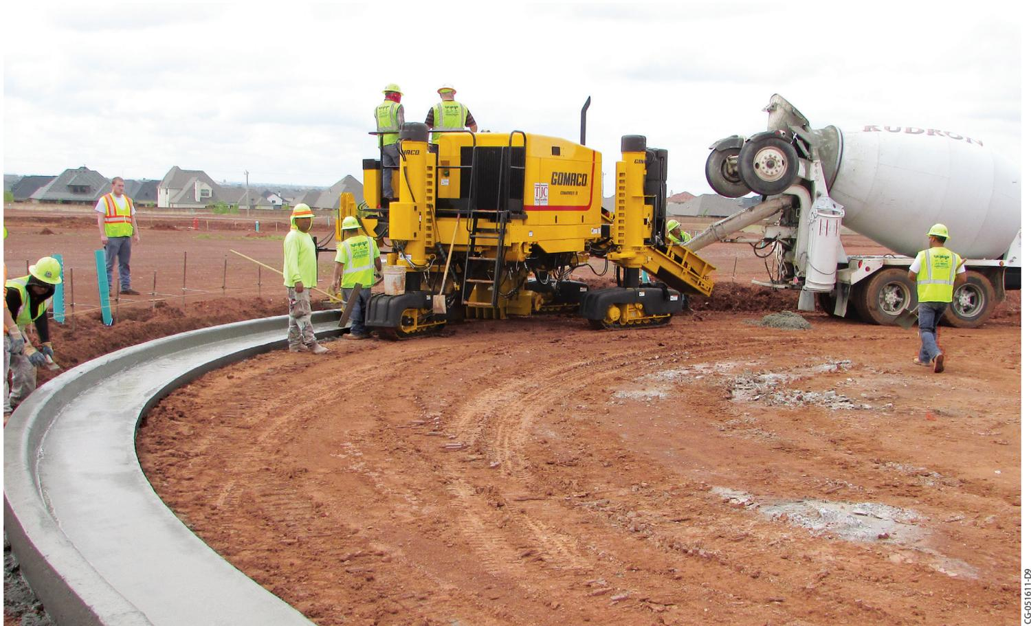
Der GOMACO Commander III mit drei Raupen fertigt eine Bordkante und einen Rinnstein. Aufgrund der Platzierbarkeit aller Raupen (ATP) des Commander III hat der Bediener mehr Möglichkeiten beim Ausweichen vor Hindernissen, der Bewältigung der Baustellenlogistik und dem Wechsel zwischen verschiedenen Anwendungen.
