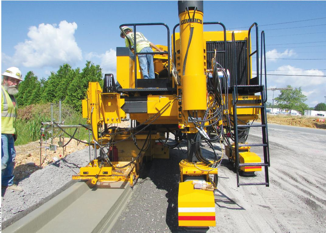
Die intelligente Platzierbarkeit aller Raupen (ATP) des GOMACO Commander IIIx ist u. a. auf intelligente Hydraulikzylinder an allen drei Stützbeinen zurückzuführen. Die intelligenten Zylinder übermitteln die Positionen aller drei Raupen an das G+ und ermöglichen ein bedarfsgerechtes Einstellen der Lenkung.
