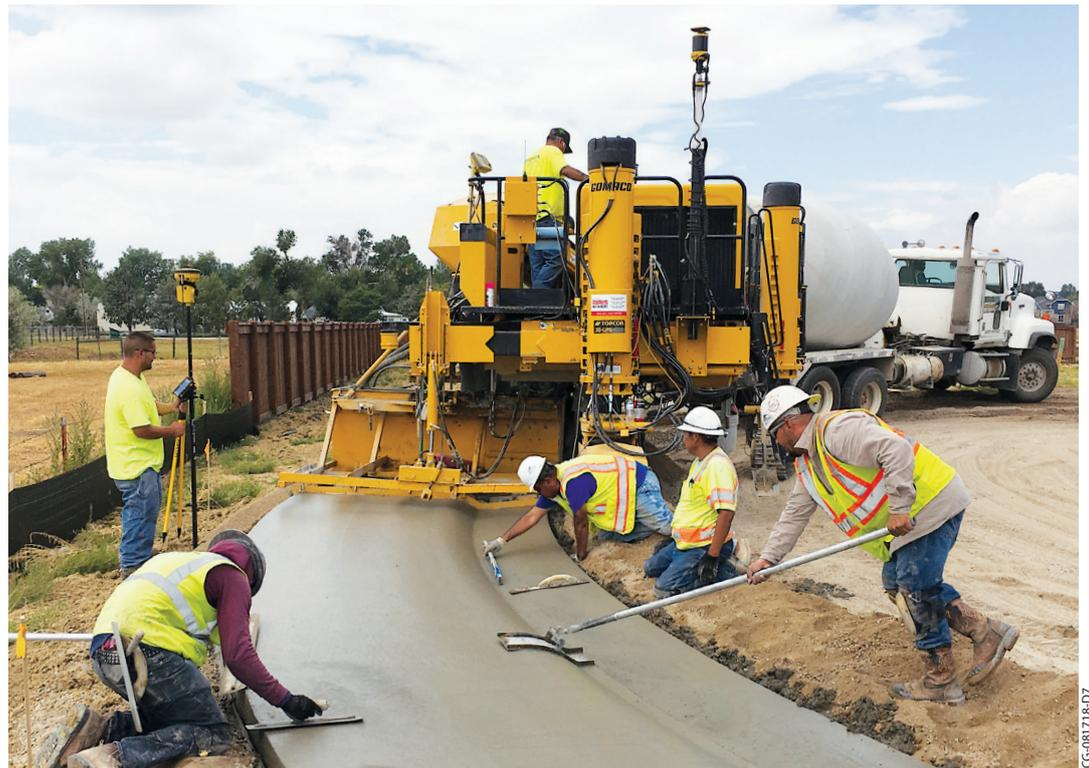
Der Commander IIIx fertigt mithilfe der 3D-Maschinenführung die Bordkante und den Rinnstein eines monolithischen Gehsteiges in einer neuen Trabantenstadt.
