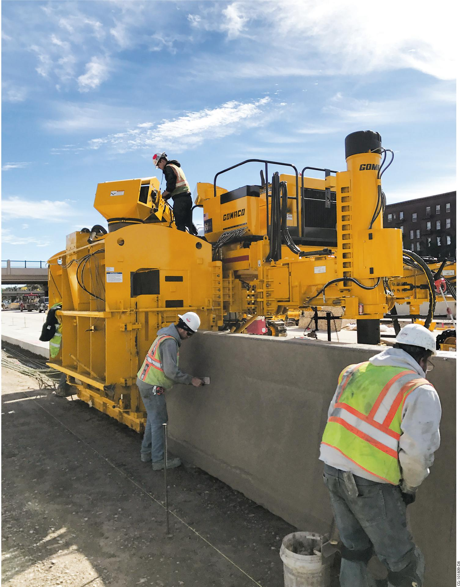
Der GOMACO Commander III mit vier Raupen fertigt eine variable Leitplanke. Dazu wird eine durchgehende Stahlbewehrung in das Schalteil eingeführt.
