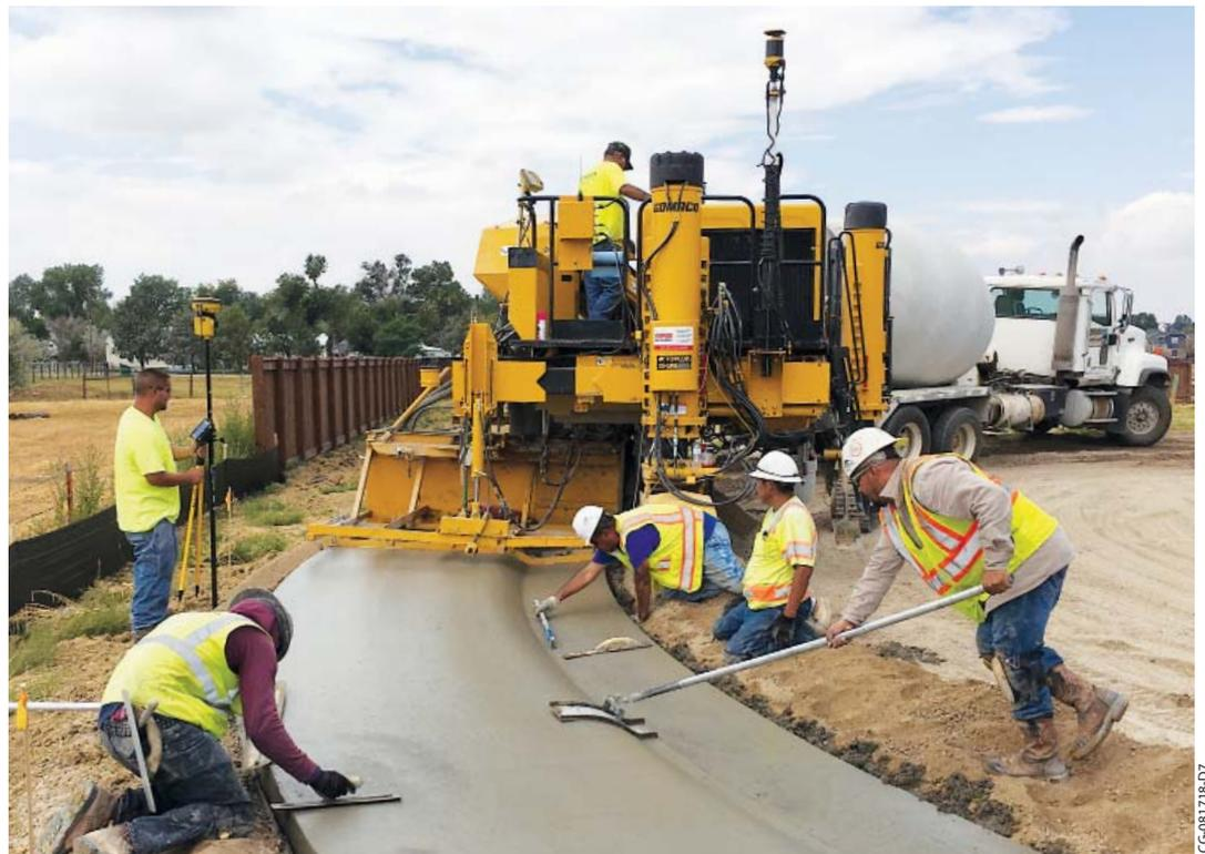
La Commander IIIx construit une bordure et un caniveau de trottoir monolithique à l'aide d'un système de guidage 3D dans un nouveau lotissement.
