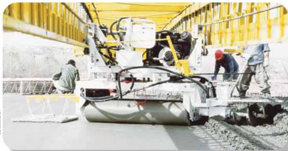
Запатентованная GOMACO система укладки "3-Point"
