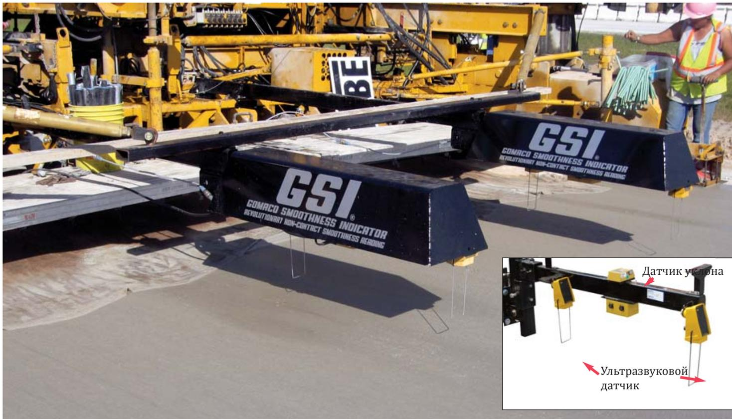
Два устройства GSI, установленные на бетоноукладчике, обеспечивают получение немедленных результатов замеров на автостраде 75, возле Пинконнинг, Мичиган.
