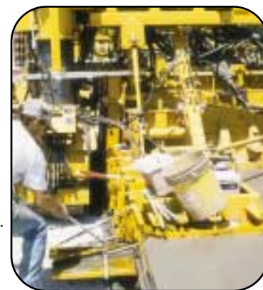
Концевая форма с ручным внедрением L-образных штырей.
