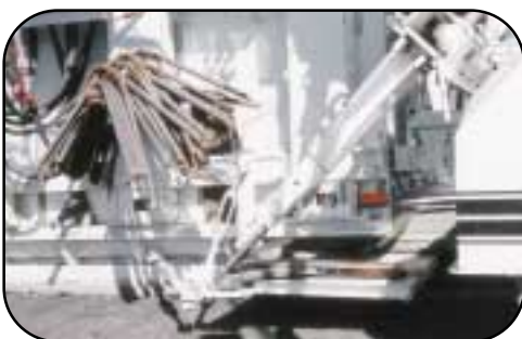
Механизм боковой укладки L-образных арматурных стержней с системой пневматического внедрения. Система пневматического внедрения используется и для установки большинства типов арматурных штырей.
