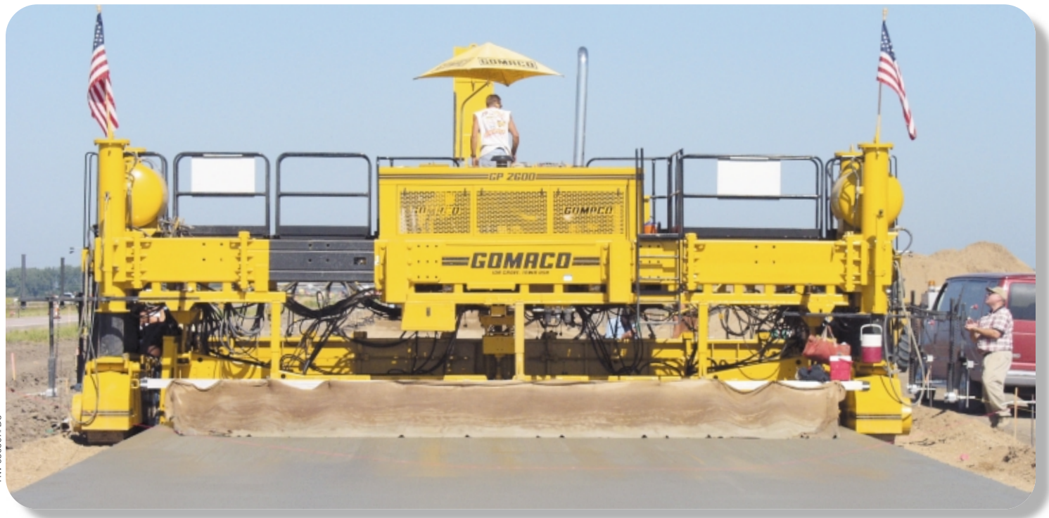
Бетоноукладчик GP-2600 на строительстве подъезда шириной 7,62 м к весовому пункту на междштатной дороге 29 в Южной Дакоте.
