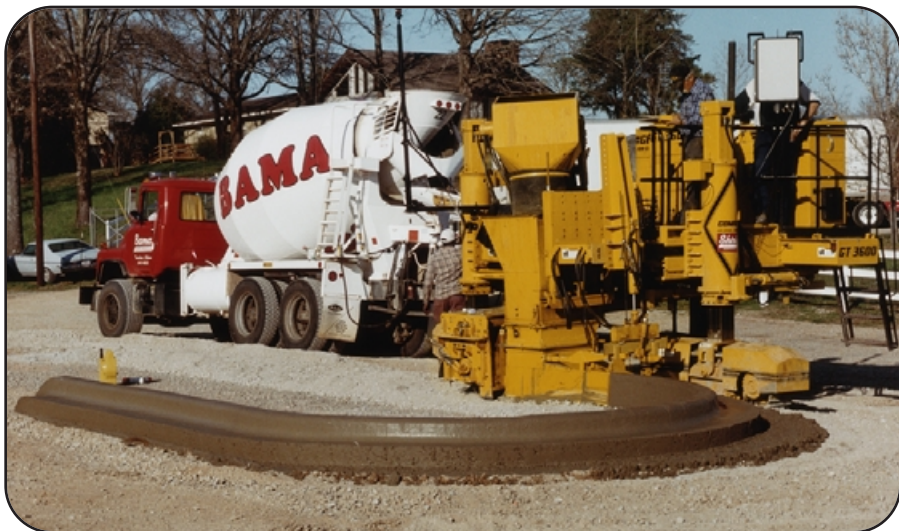
Une première mondiale à Northport, Alabama : bordure et caniveau réalisés par une machine de coffrage glissant GT-3600 sans fil à l'aide du système de guidage sans fil Leica.
