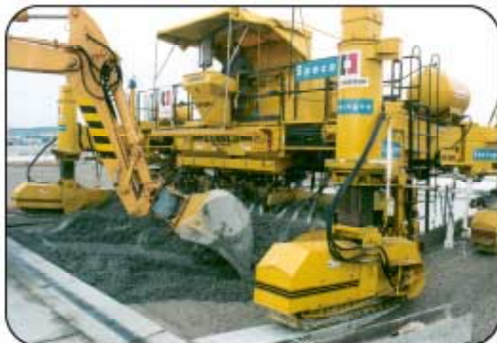
Начало и конец плит должны соединиться с существующим шоссе, так что при укладке нужно тщательно соединить их.
