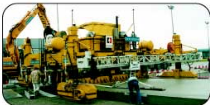
Использование специальной, очень жесткой бетонной смеси использовалось, чтобы обеспечить необходимую точность укладки бетонной полосы шириной 23 фута (7.01 м) и 14.2 в. (361 мм) толщиной
