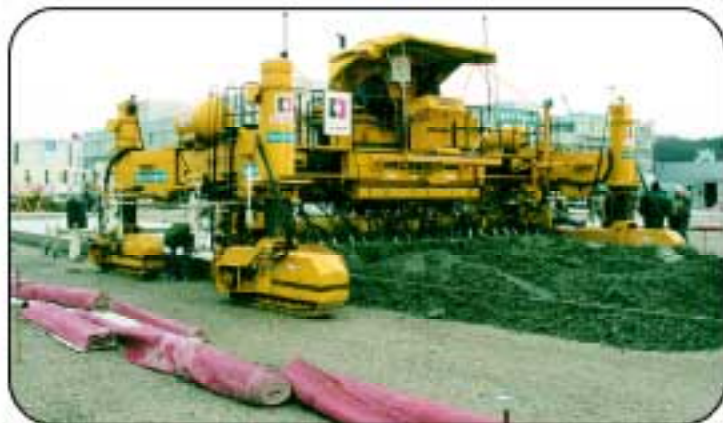
Порядчик Specogni-Switzerland оборудовал машину GOMACO GHP-2800 укладываемой скользящей формой с системой управления Stringless для строительства взлетной полосы в Цюрихском Аэропорту в Zurich-Kloten, Швейцарии, в декабре 1999.
