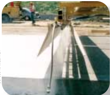
Навесной распылитель для распределения пленкообразующего материала
