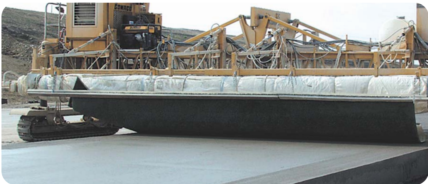
Гибкость при обработке бетонной поверхности волочением брезента, мешковины или нанесения полиэтиленовой пленки.
